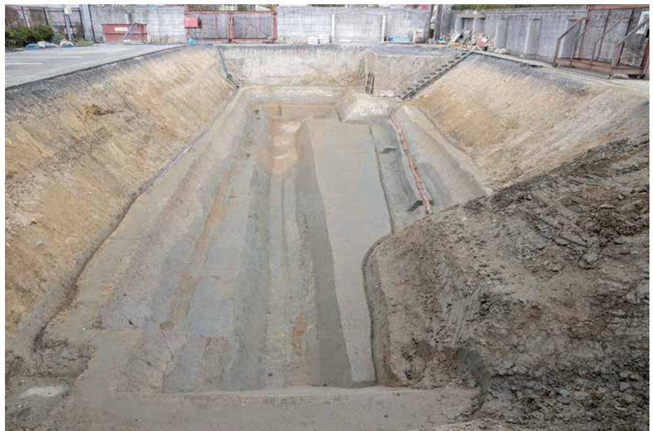
(3) C10区 調査区完掘状況全景 (南から)
