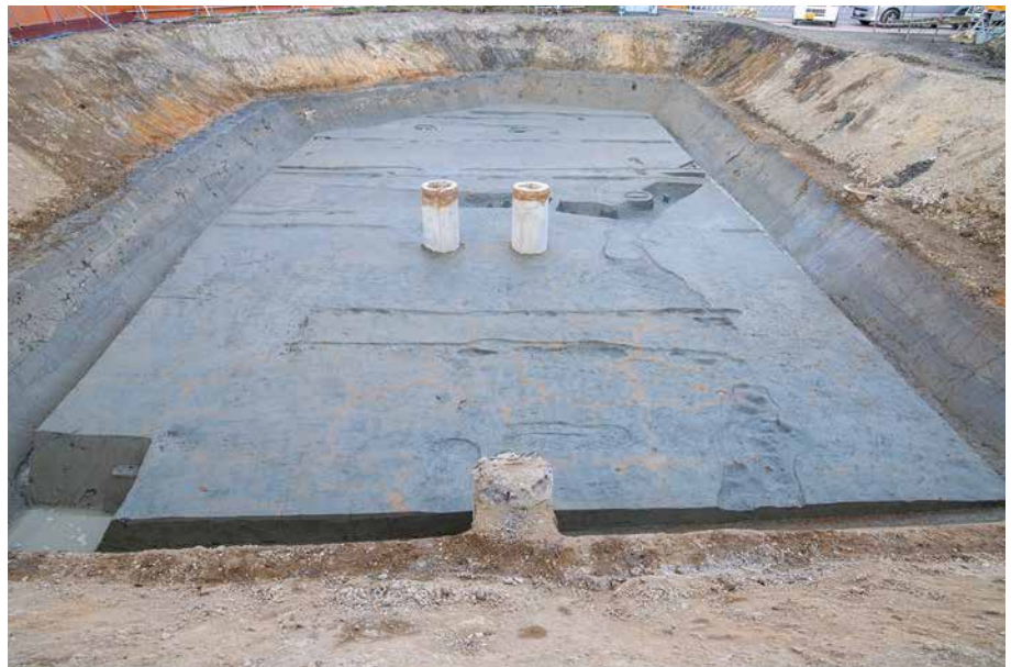
(2) C13区 調査区全景(南から)
