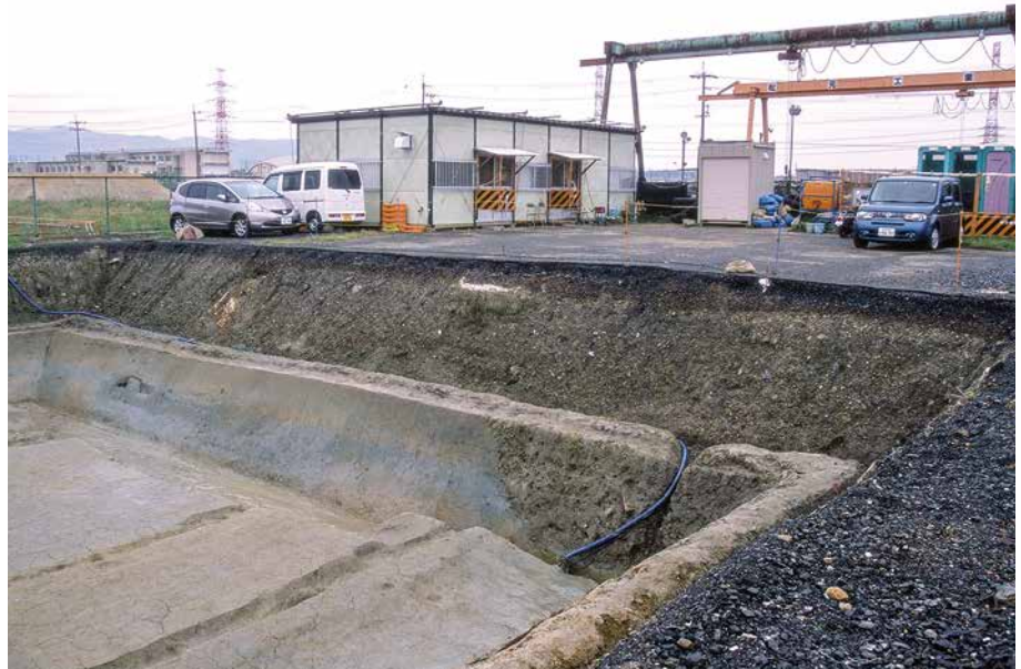
(2) G 9 区 南壁土層(北西から)
