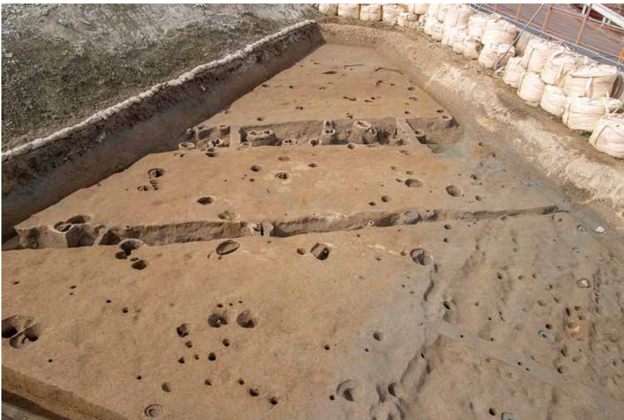
(2) D13区 溝 S D04・05 検出状況(南東から)
