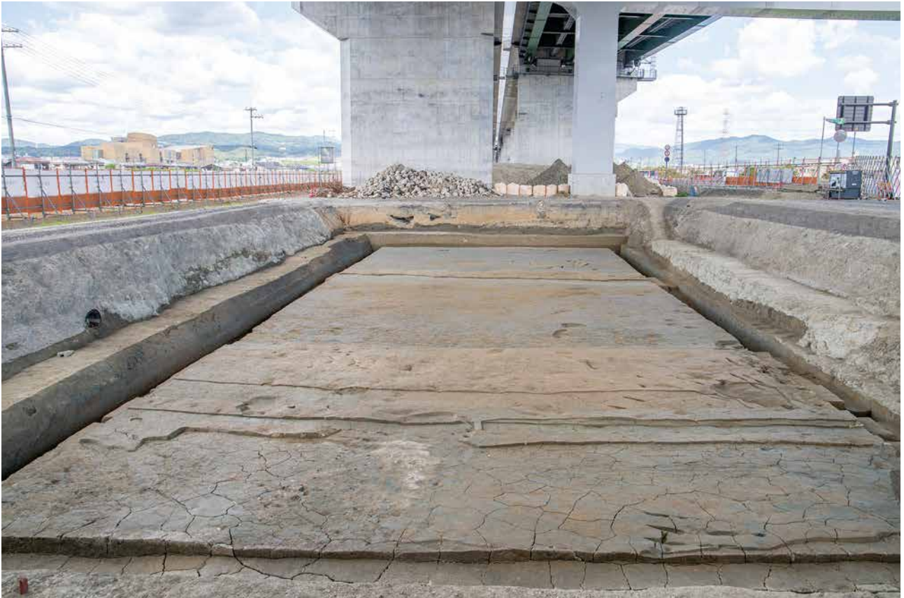
(1) G18区 調査区全景(西から)
