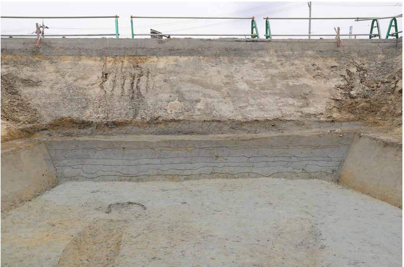
(2) E 6 a区 北壁土層(南から)
