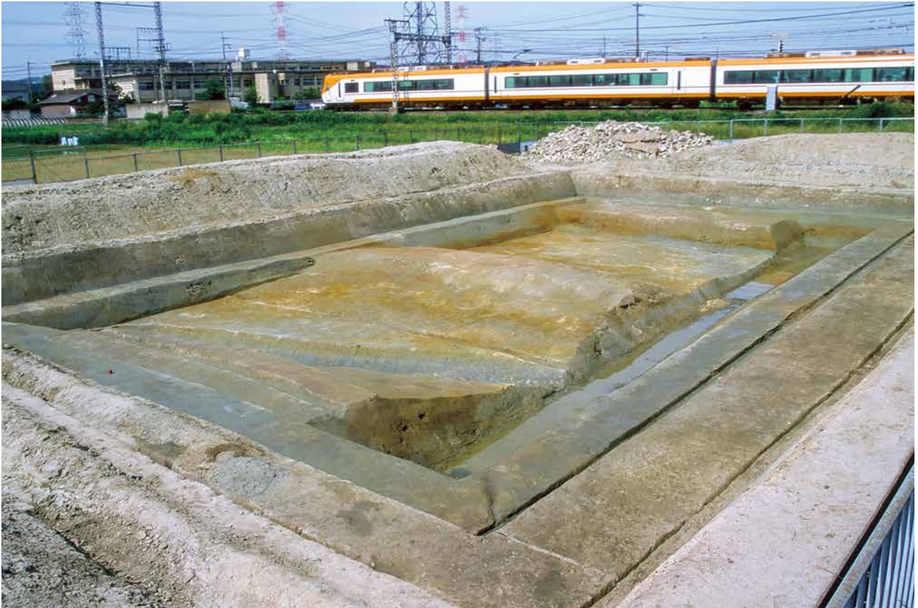
(1) D 3 区 調査区全景(北東から)
