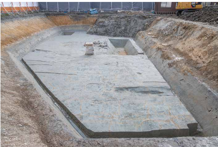
(3) C12区 下層断ち割り状況 (北から)
