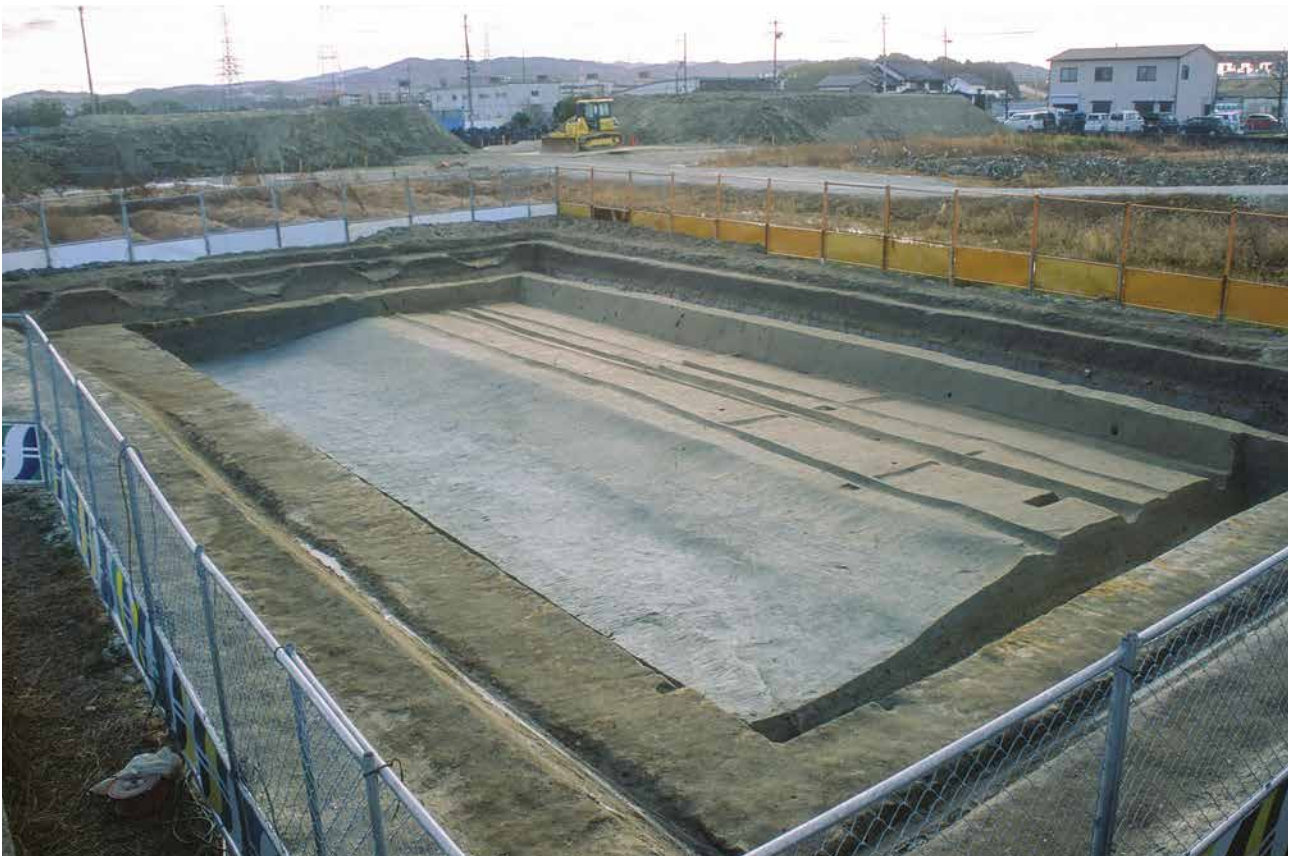
(2) F 2 区 調査区第 3 面全景(北東から)
