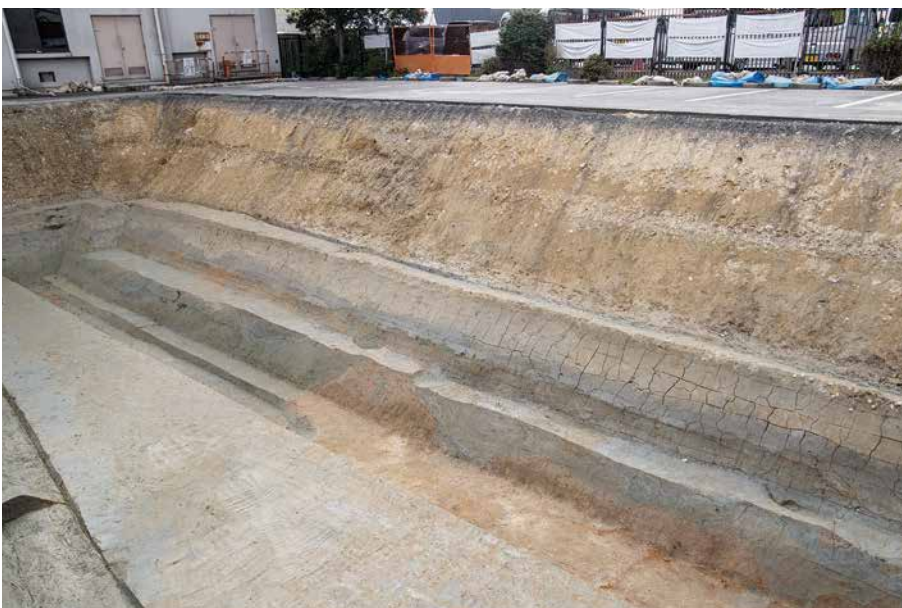
(3) C10区 西壁土層(北東から)
