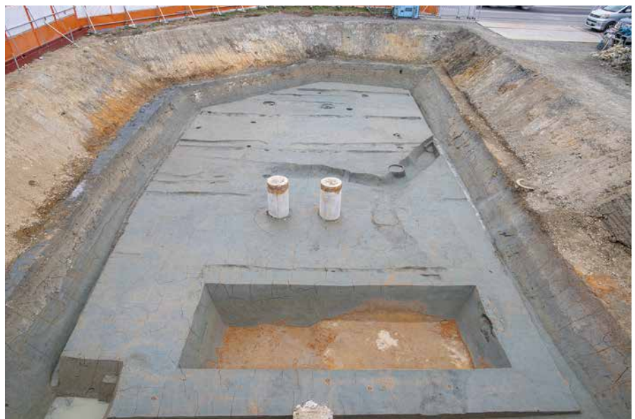
(3) C13区 調査区断ち割り後 全景(南から)
