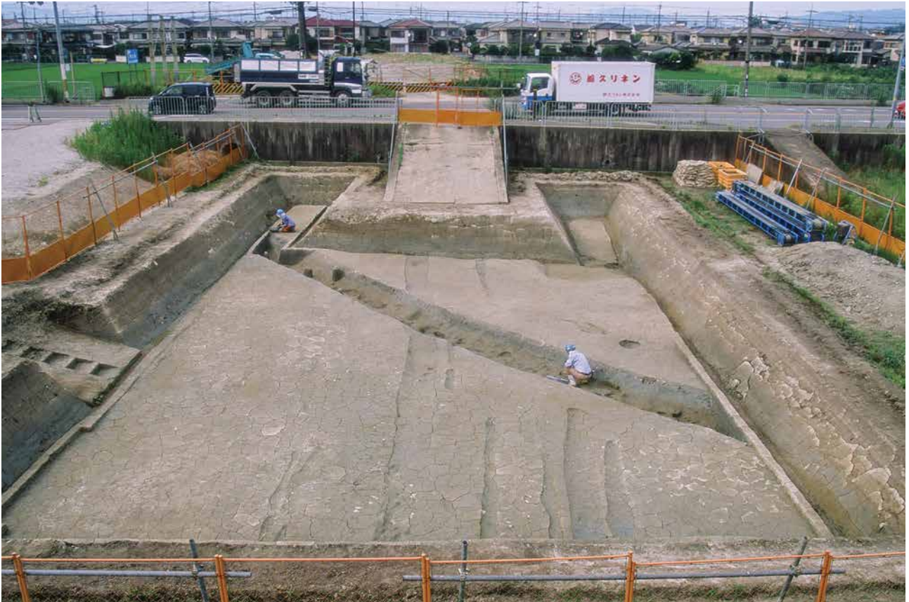
(1) G 6 区 調査区全景(南から)
