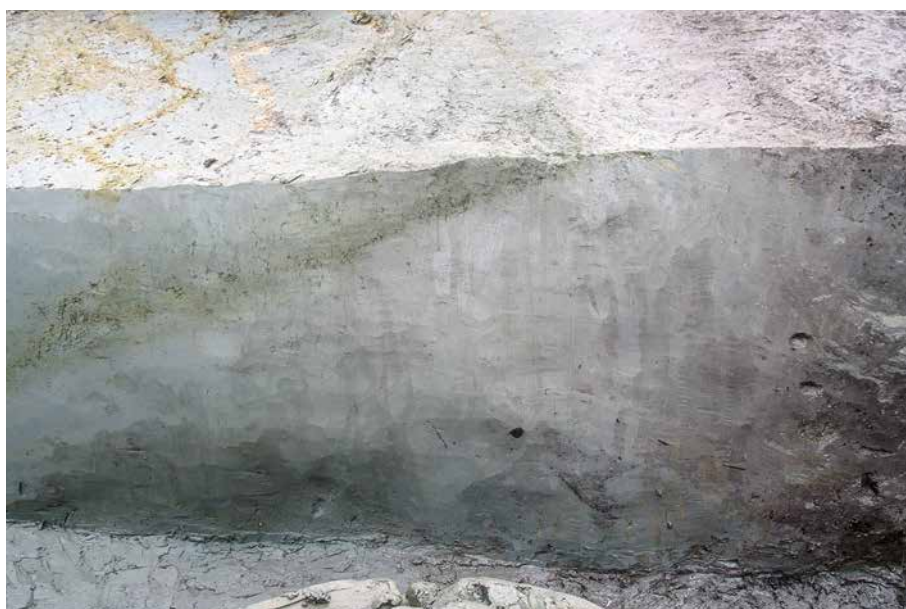
(2) G 10区 流路N R 11南壁土層 (北東から)
