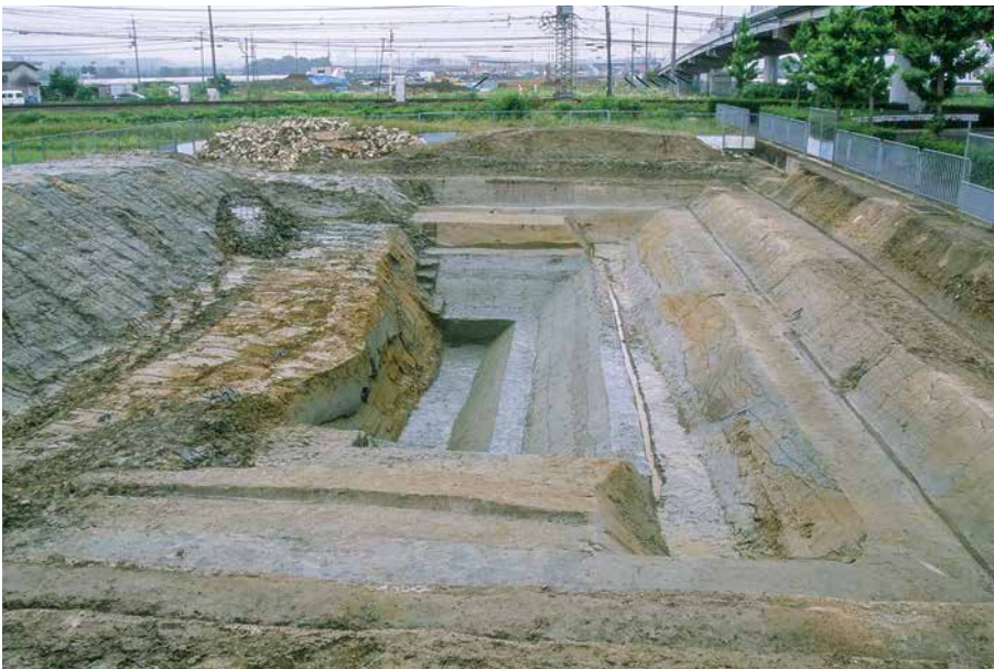
(2) D 3 区 断ち割り状況 (東から)
