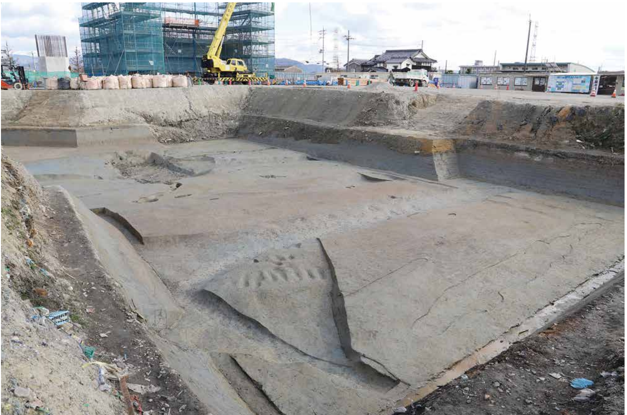
(2) E 6 b区 調査区下層全景(北東から)
