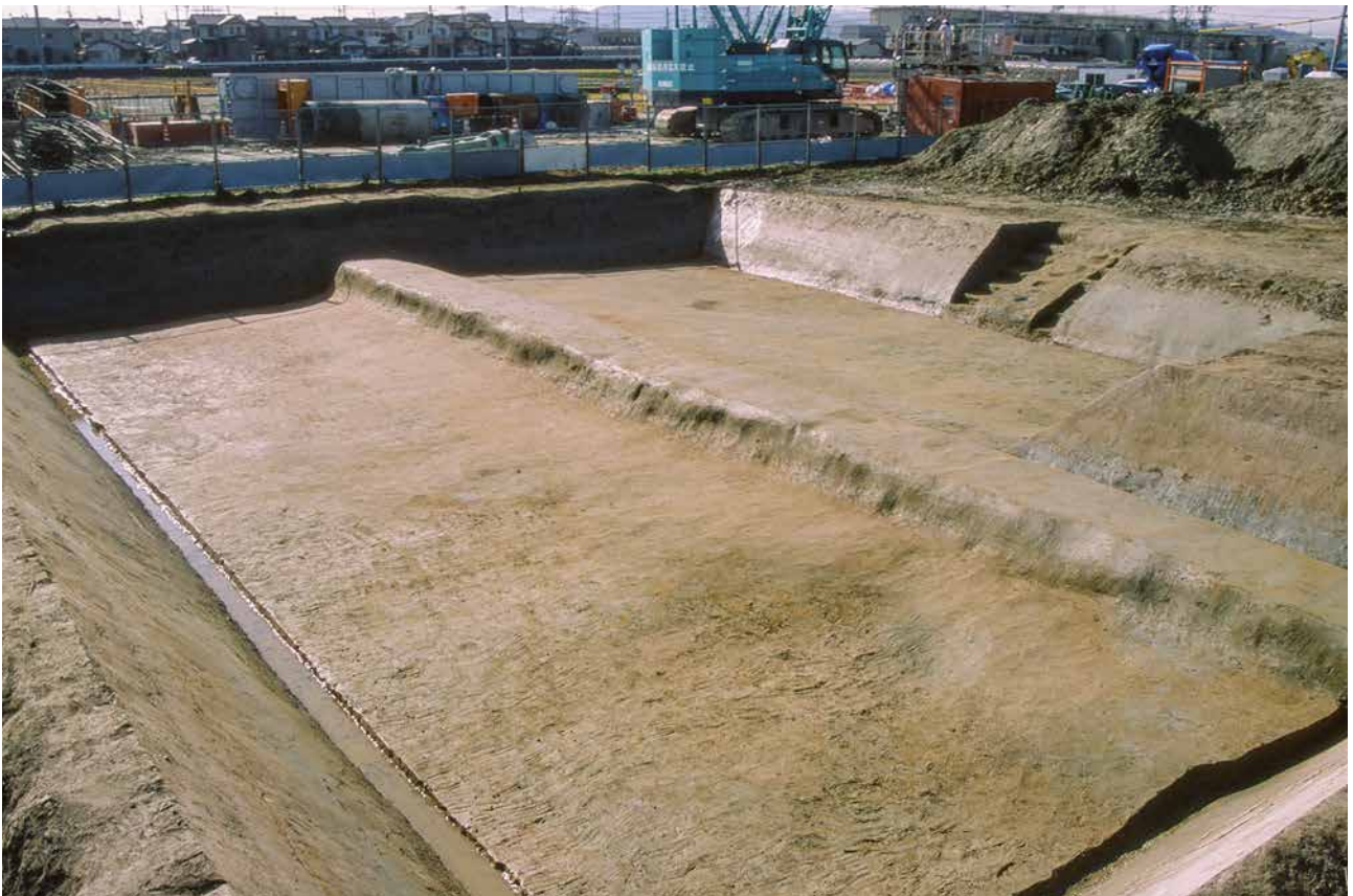
(2) D 6 区 調査区全景(北東から)
