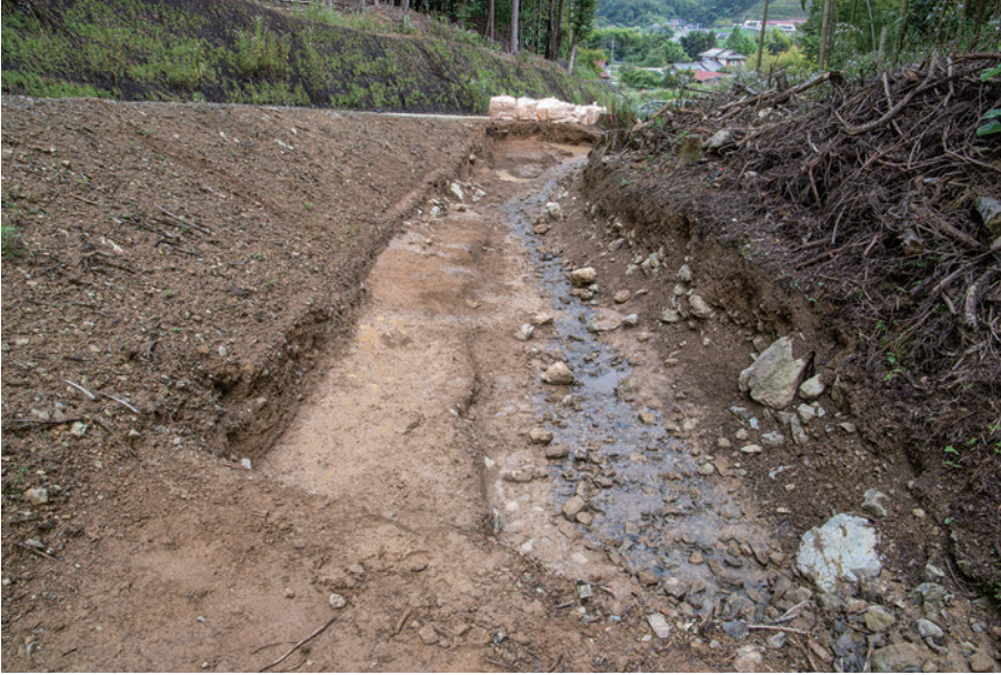
(1) B地区調査後全景 (北西から)
