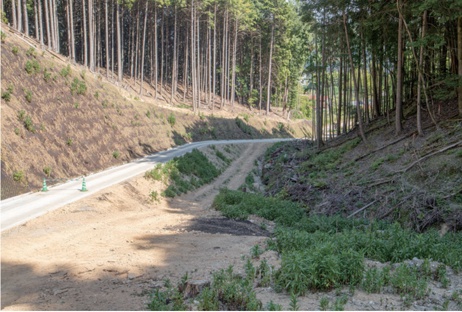
(1) A 地区調査前全景 (北西から)
