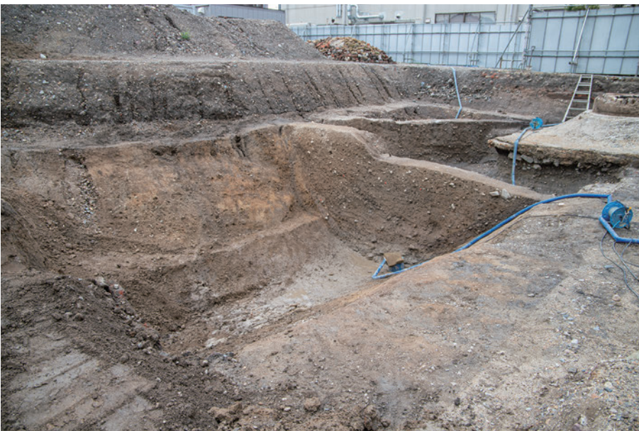
(3) 4区区画溝 S D420完掘状況 (北西から)
