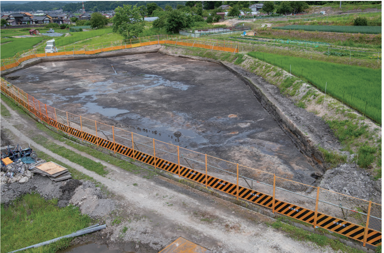
(2) 1区上層検出状況(北西から)
