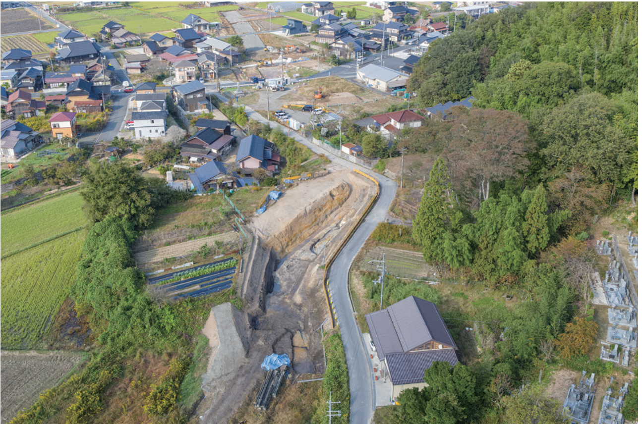
(2) 7区空撮(東から)
