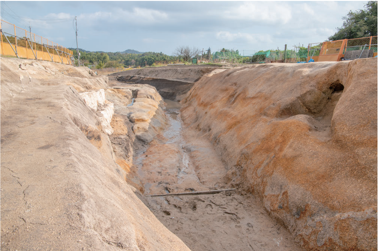
(2) S D7001完掘状況(西から)
