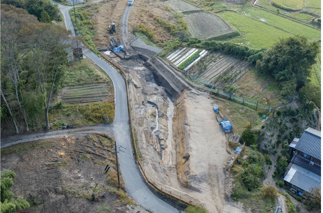
(1) 7区空撮(西から)
