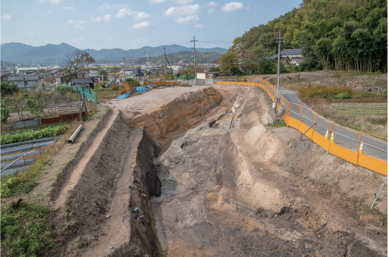
(1) S D7001完掘状況(東から)
