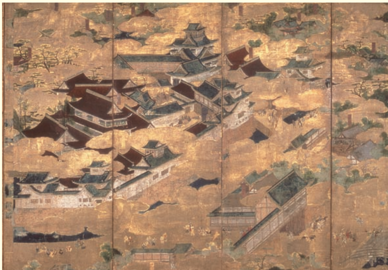
『聚楽第図屏風』部分（公益財団法人三井記念美術館所蔵） 屏風に描かれた聚楽第の建物の屋根は金色に縁取られています
