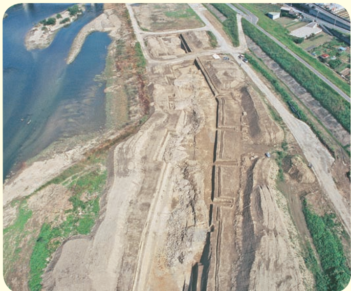
水制と護岸が交互に連なっています
