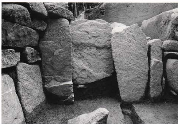
▲ 板石により閉ざされた玄室
