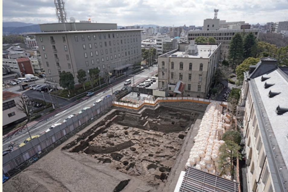
調査地南半近景(北西から)
