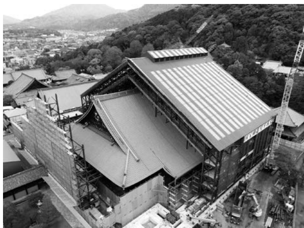
写真2 国宝知恩院本堂の素屋根撤去の様子 (2018年4月10日、京都新聞社提供)
