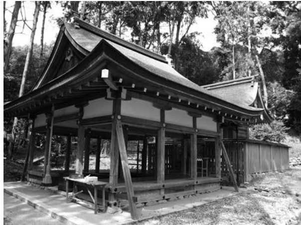
写真1 暫定登録文化財・賀茂別雷神社摂社大田神社 拝殿・本殿(京都市北区)
