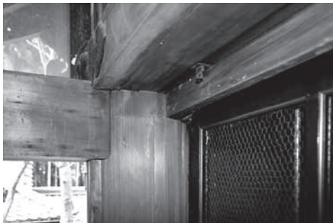
写真3 正面隅柱 板挟り・付鴨居・建具吊金物痕跡
