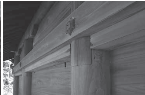
写真4 背面柱 内法長押下埋木
