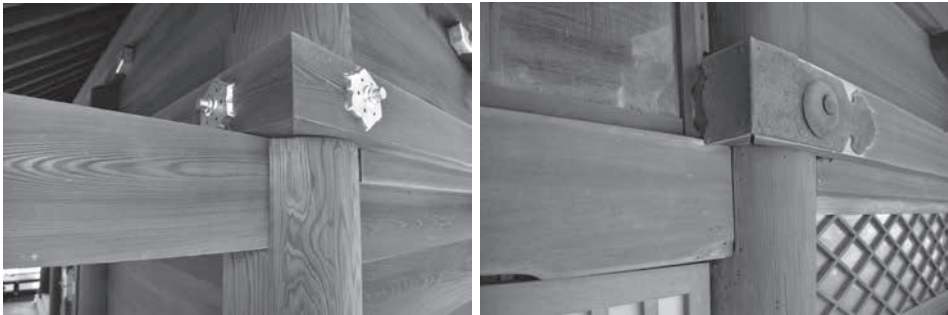
写真13、14 繫梁と内法長押の納まり(左：下鴨社本殿、右：宝塔寺七面堂)
