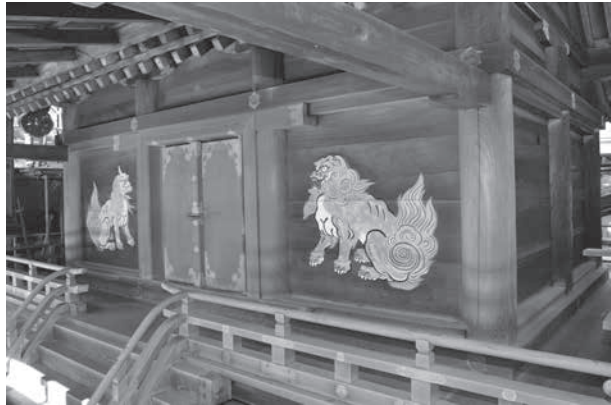
写真16 上賀茂社本殿 正面(修理工事中写真)
