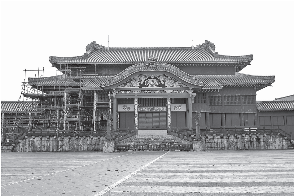
首里城正殿（左側は漆塗り替え作業が行われていた）
