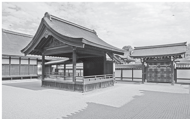
写真3 本願寺重要文化財・能舞台(北西から)
