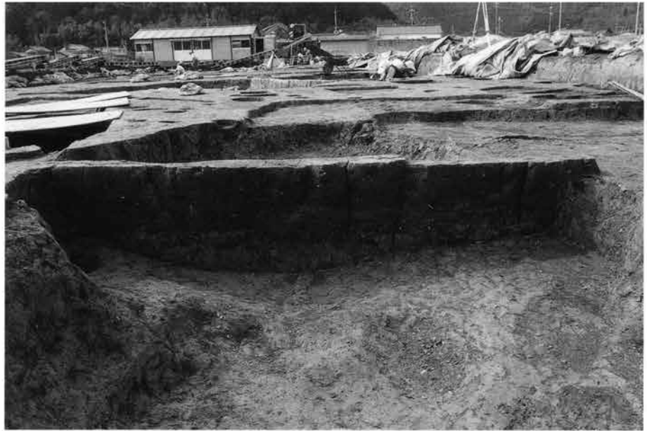
(1)土坑 S K515断面(東から)
