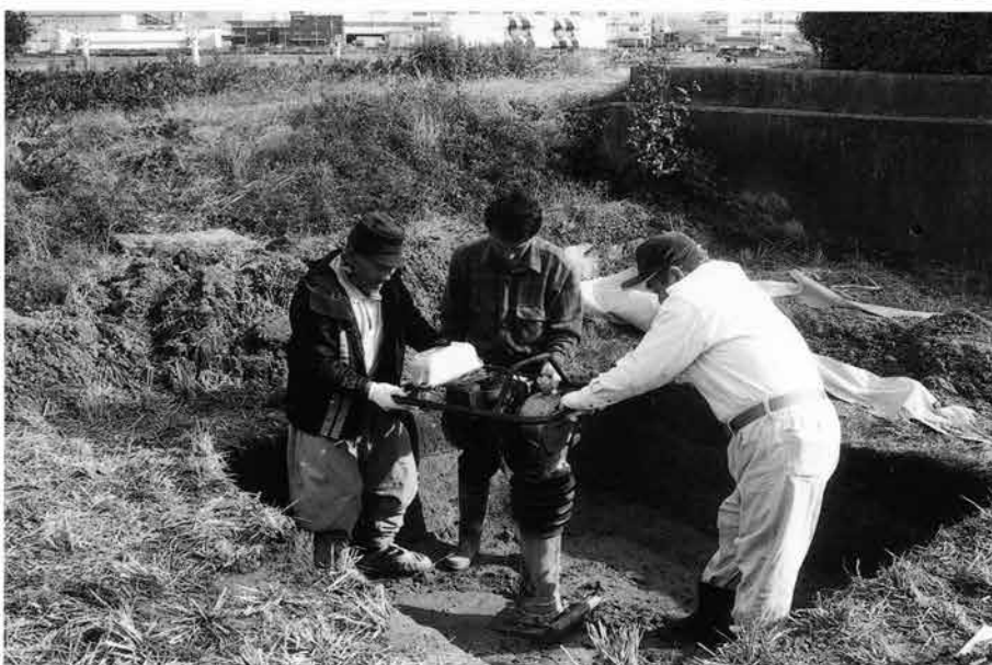
(3)門田4トレンチ埋め戻し 転圧作業(西から)
