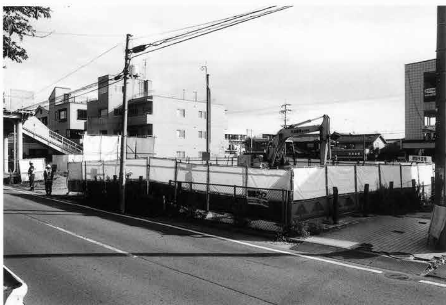
(1)調査前全景(東西から)
