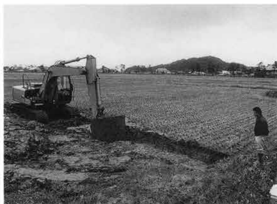
第32図 宮遺跡重機掘削風景
