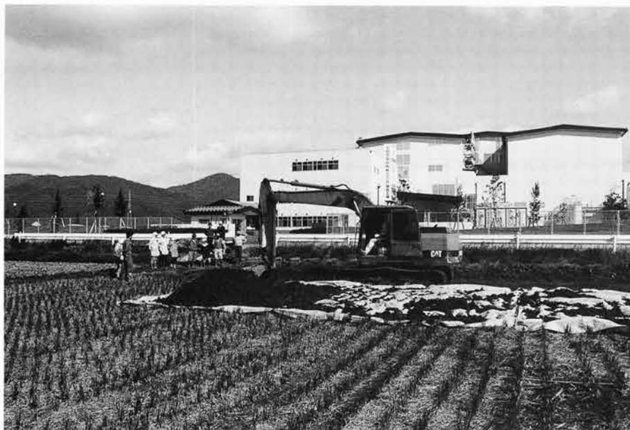
(1) A地区重機掘削風景(西から)
