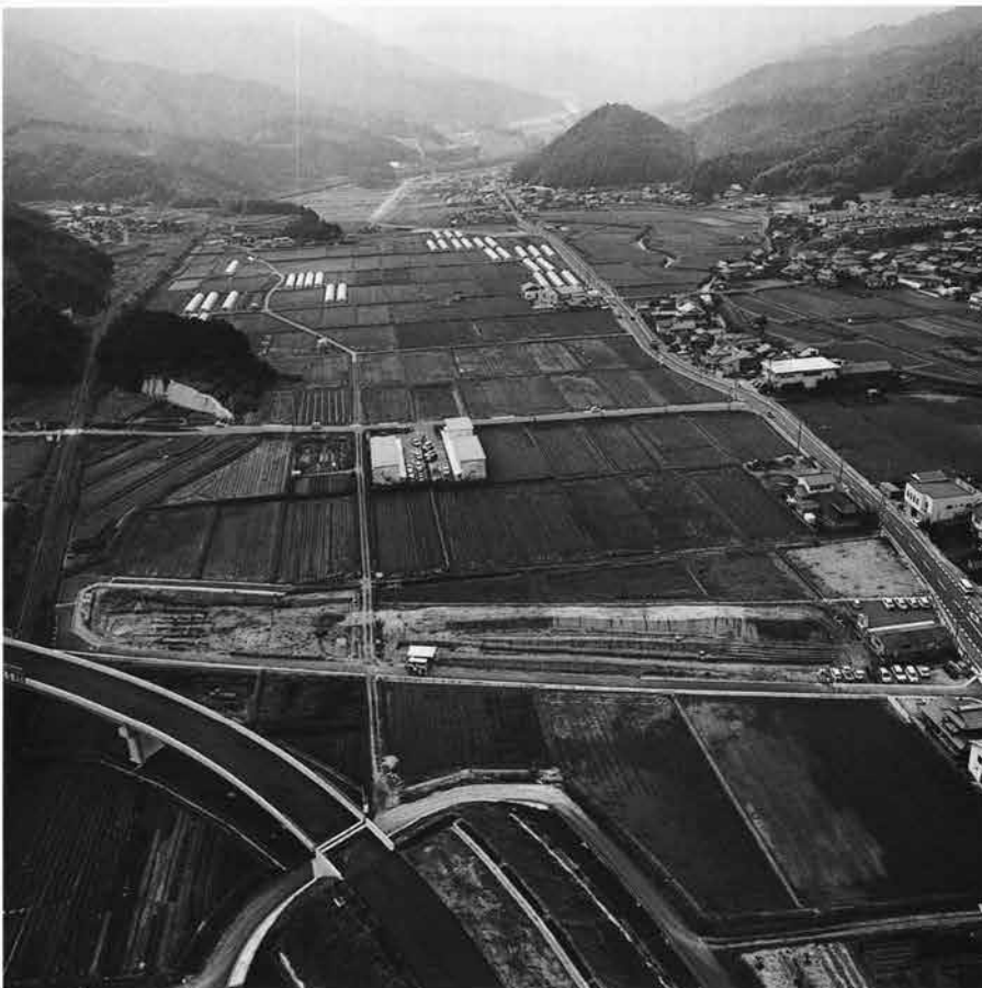
(2) 調査地遠景(北から)
