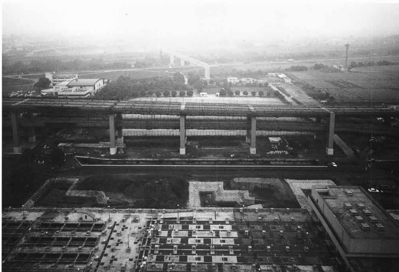
(1) 調査地全景(南から)
