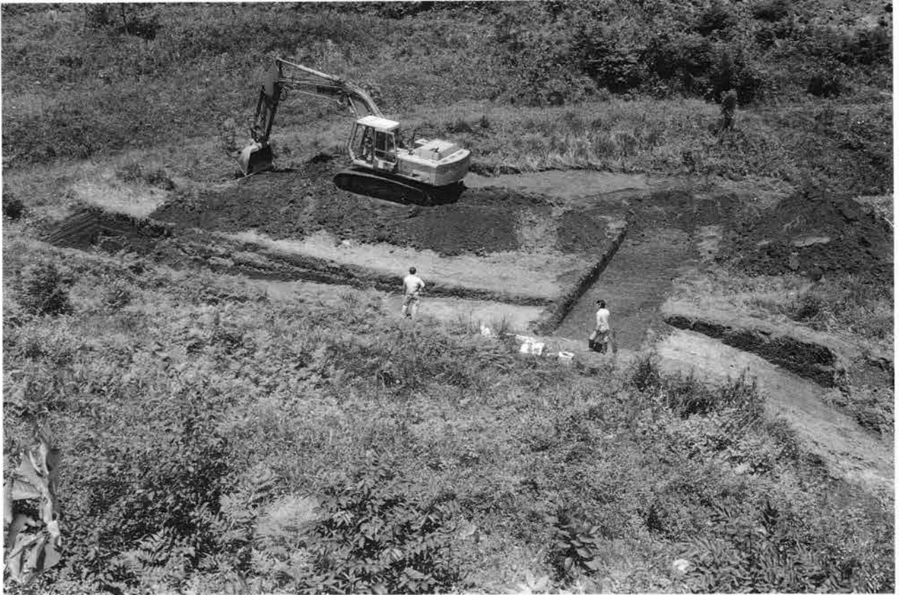
(1)大俣城跡D地区重機掘削状況（南から）
