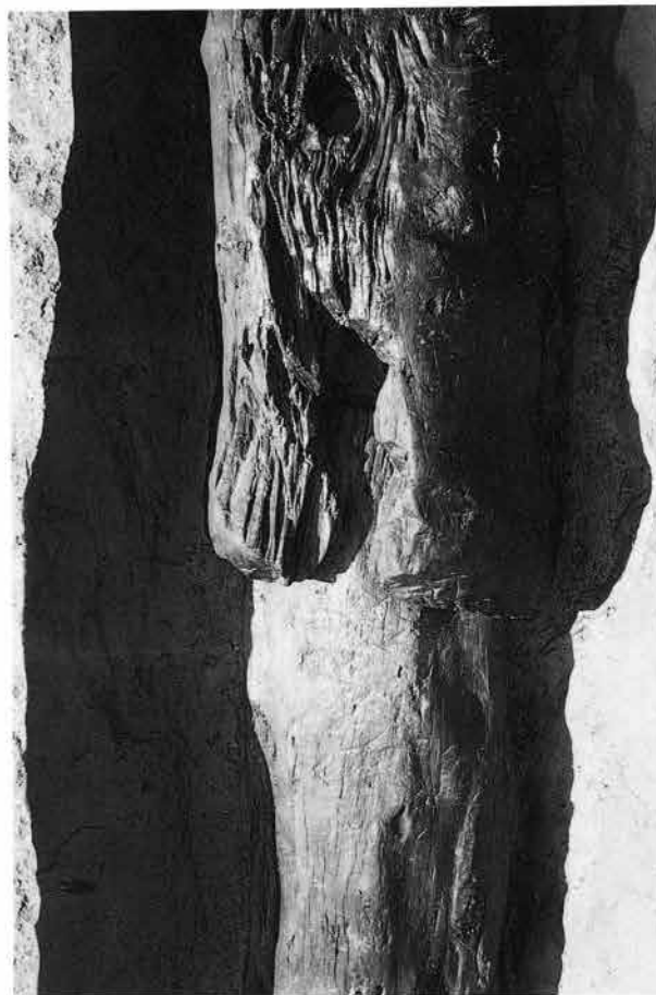
(4)木製暗渠結合部 (北から)
