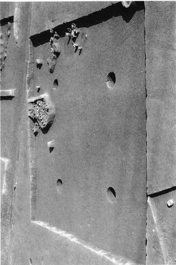
(1) S H05全景 (南西から)
