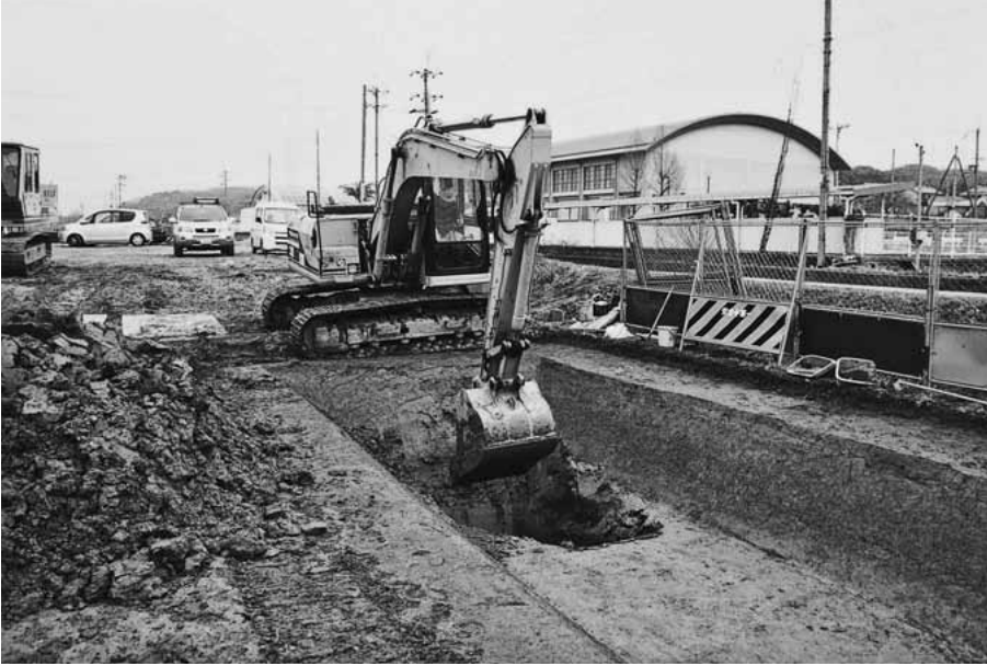
(1) 第8トレンチ断ち割り作業 (南西から)
