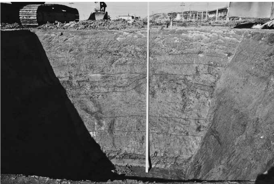
(3) 第6トレンチ北壁土層断面 (南から)
