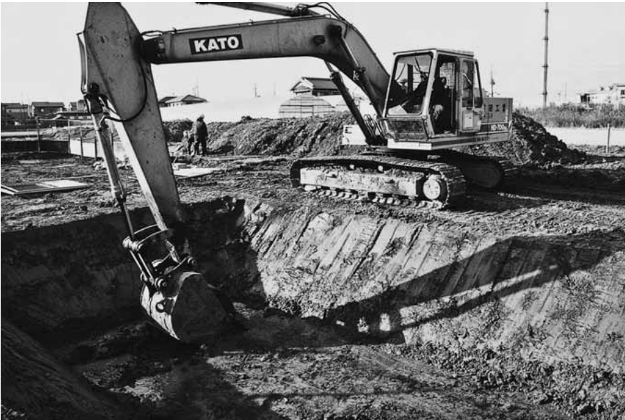
(2) 第6トレンチ重機掘削作業 (北東から)
