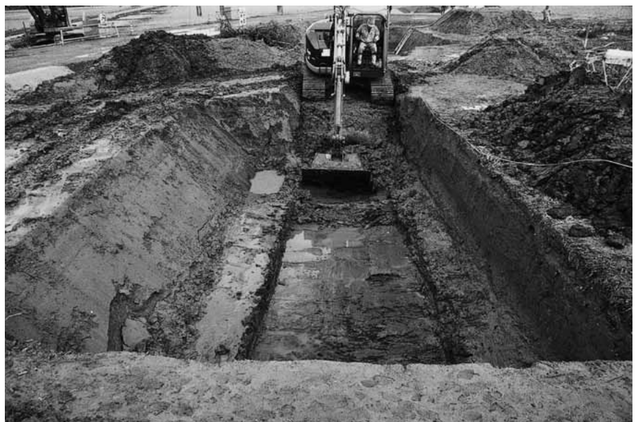
(3) 7トレンチ重機掘削(南から)
