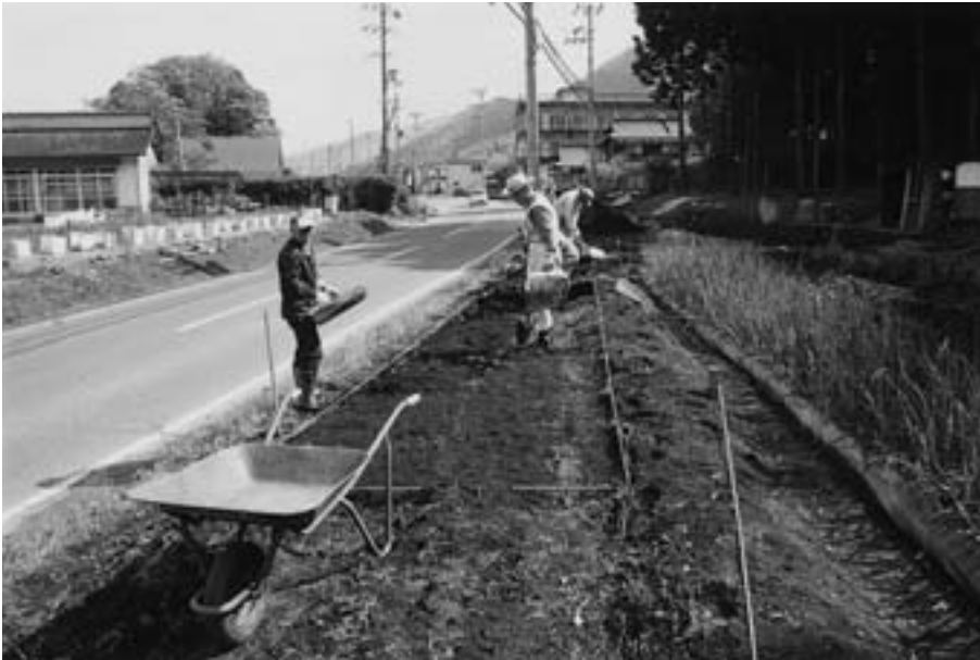
(1) 2区作業風景(南西から)
