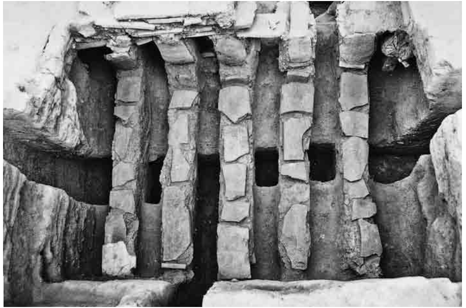
(1) 5号窯焼成室畦構築状況 (西から)
