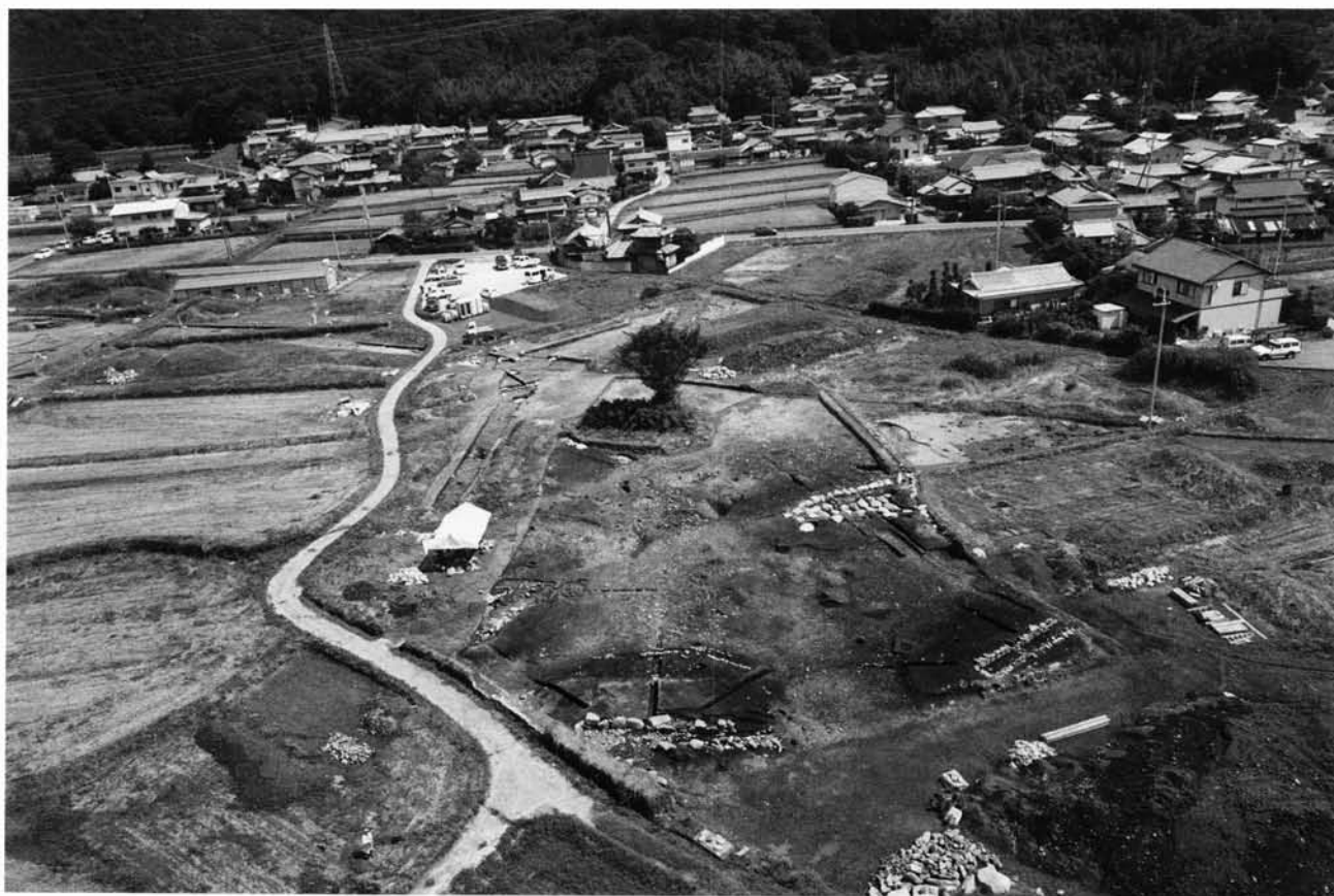
(1)D4地区全景(西から)
