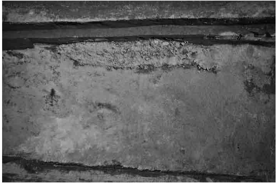
(1) C 区水制 S X 4 (上が南東)
