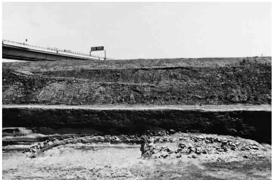
(3) C 区水制 S X 4 断面 (北西から)
