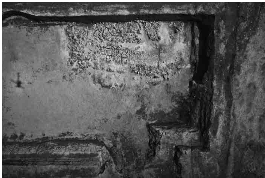
(2) C区水制 S X 6 (南東から)
