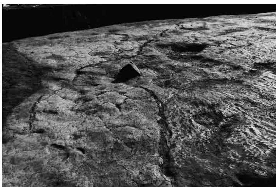
(3) E 区噴砂跡検出状況(北西から)
