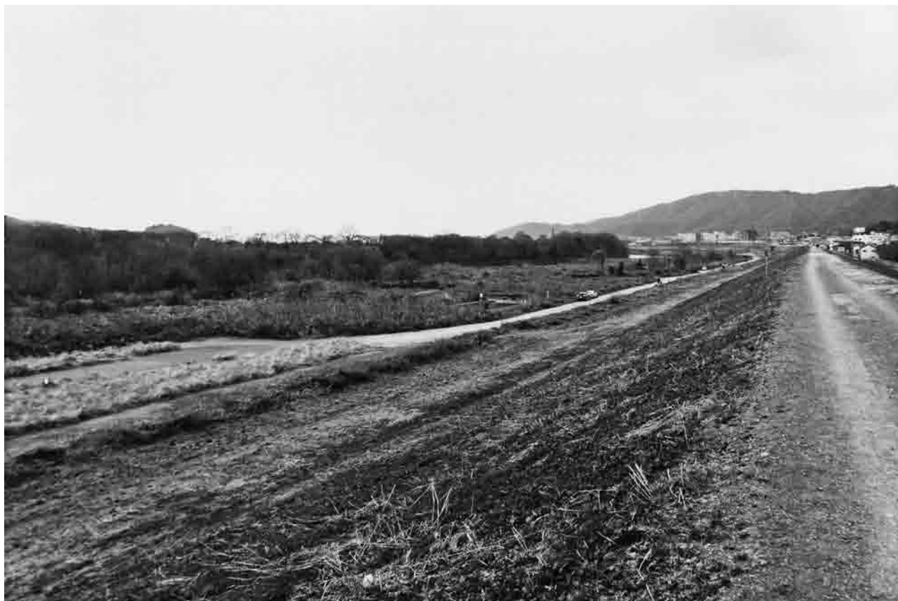
(1) 第17次調査地近景(北東から)
