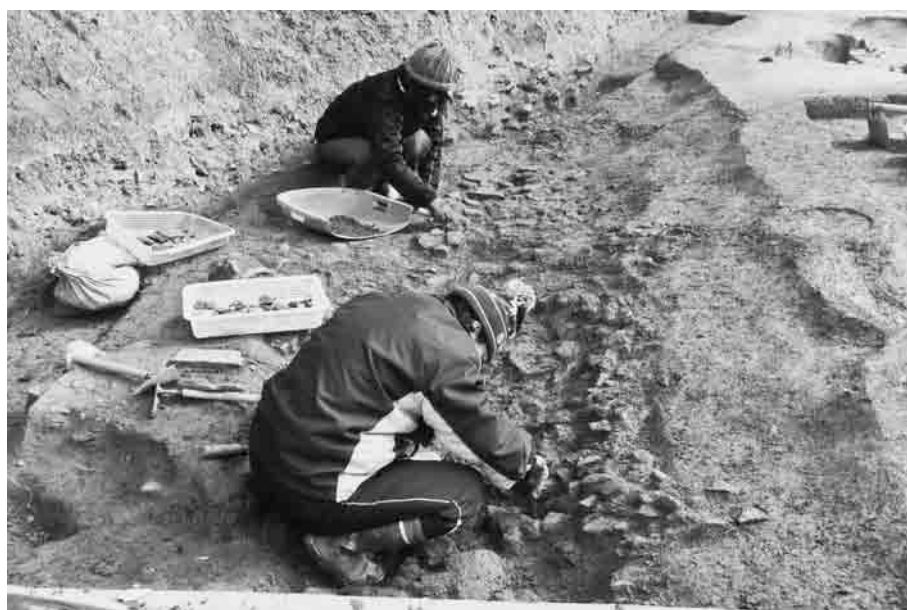
(3) 雨落ち溝 S D293 検出作業 (西から)
