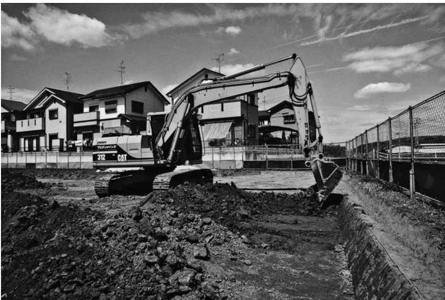
(3) A 2 地区重機掘削作業(南から)
