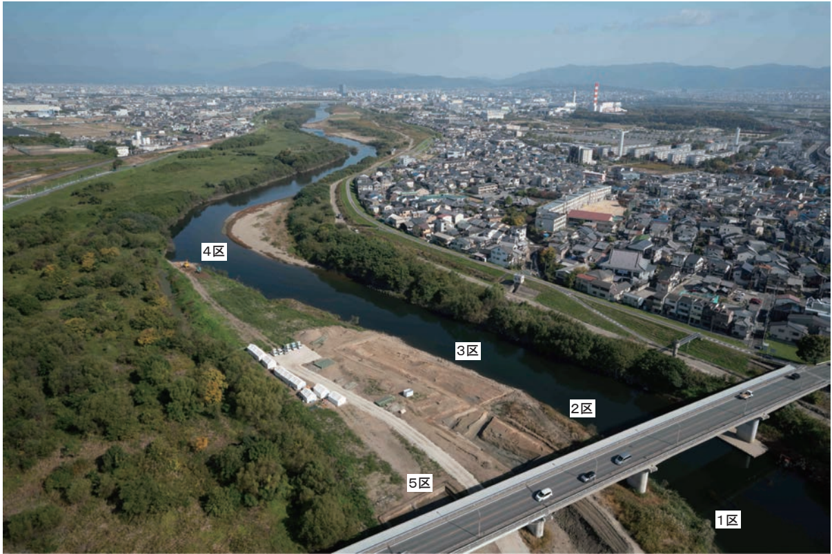
写真1 調査地遠景(南西から)
