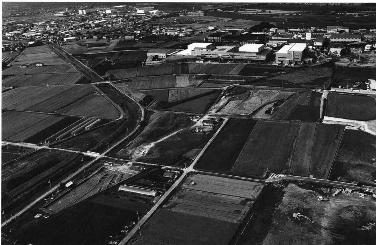
(1) 調査地全景 (南東方向上空から)
