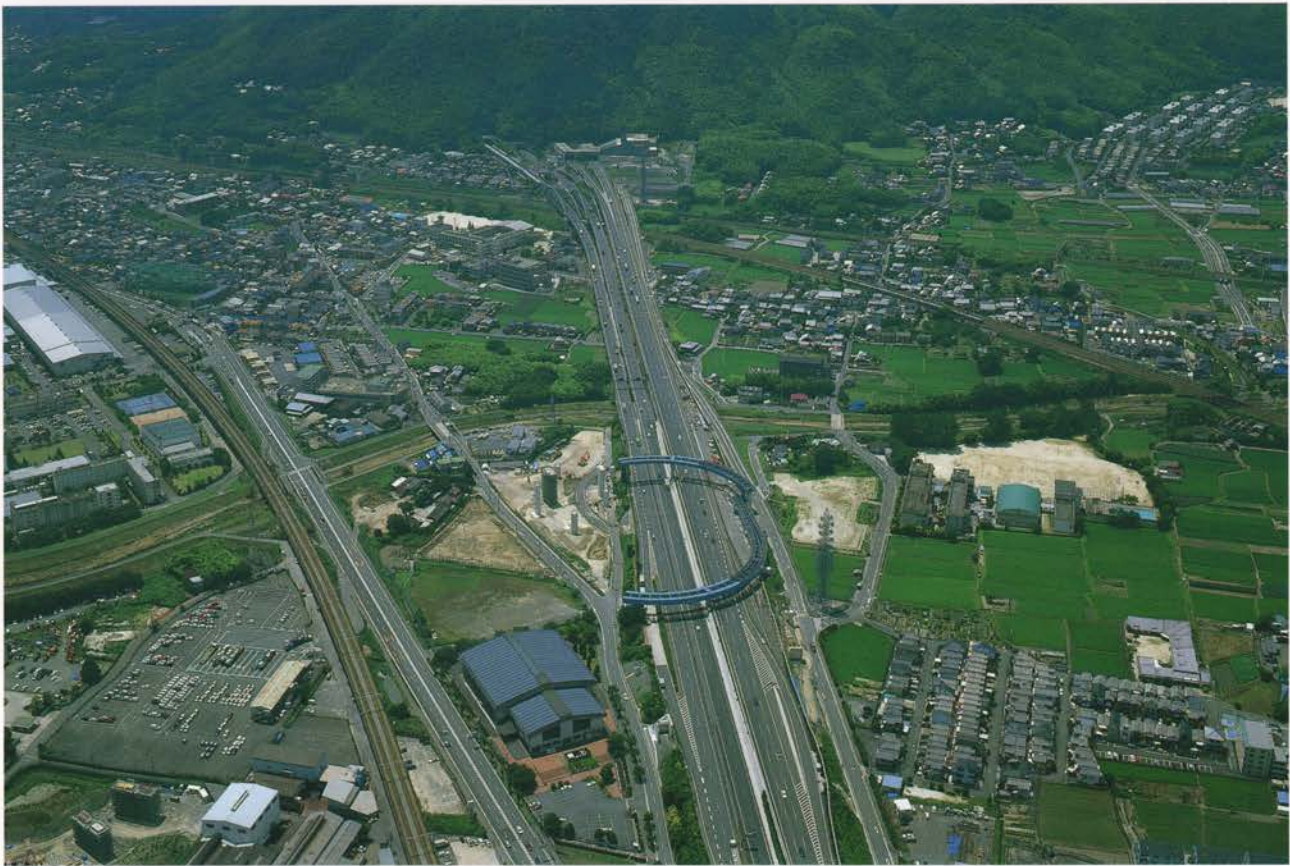
(1)調査地遠景(東から)
