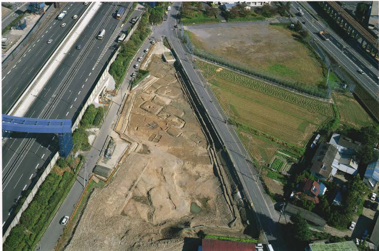
(2)F 地点下層遺構完掘状況(西から)
