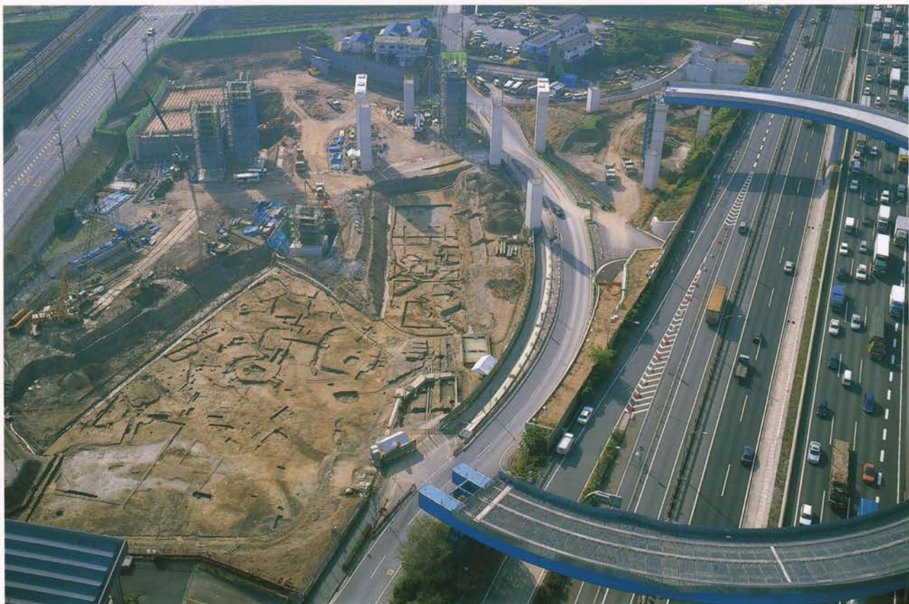
(2)I・J地点完掘状況(北東から)
