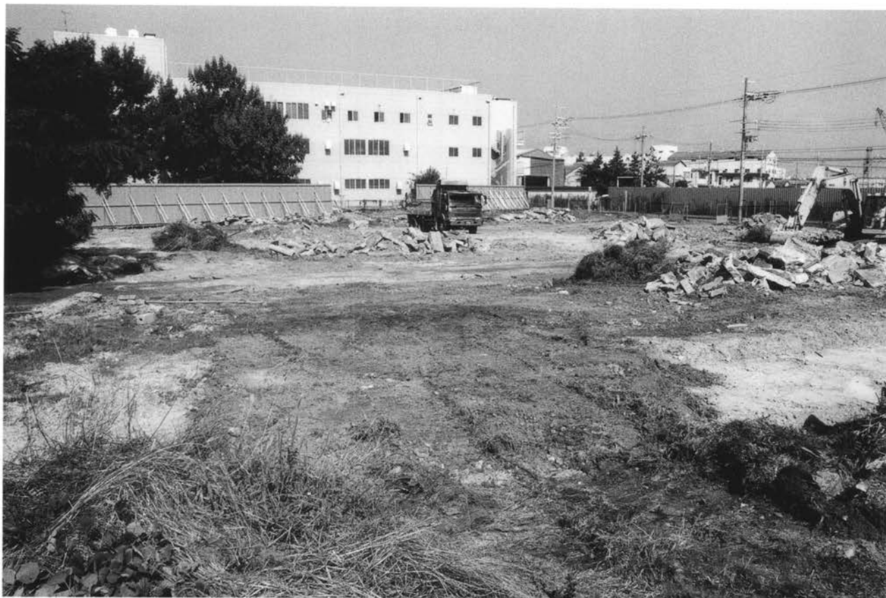
(1) B-1 地区調査前全景(南東から)
