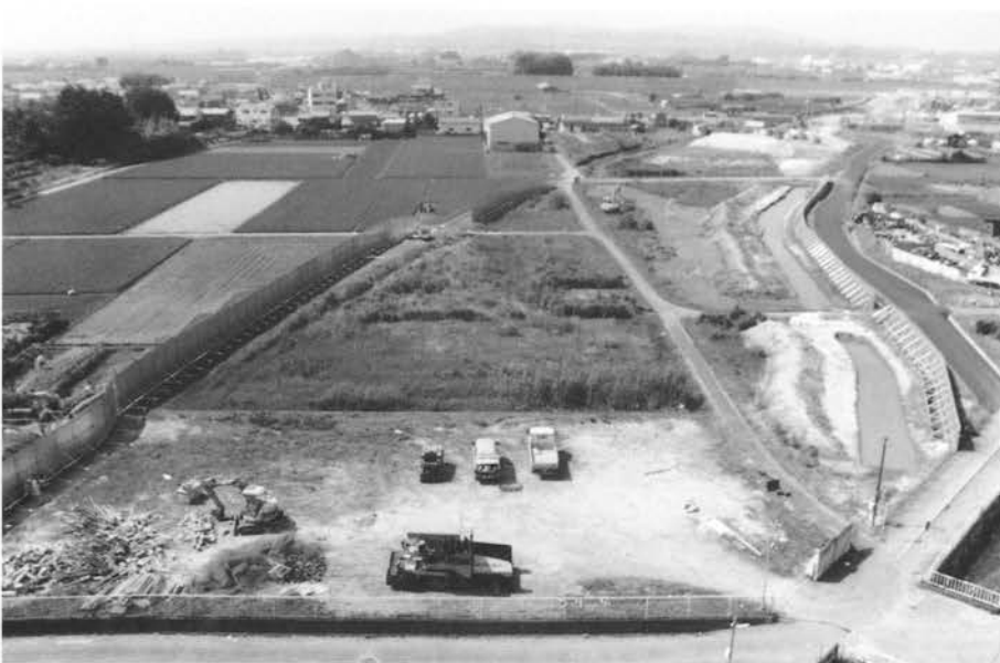
(3) 調査地調査前全景(北から)
