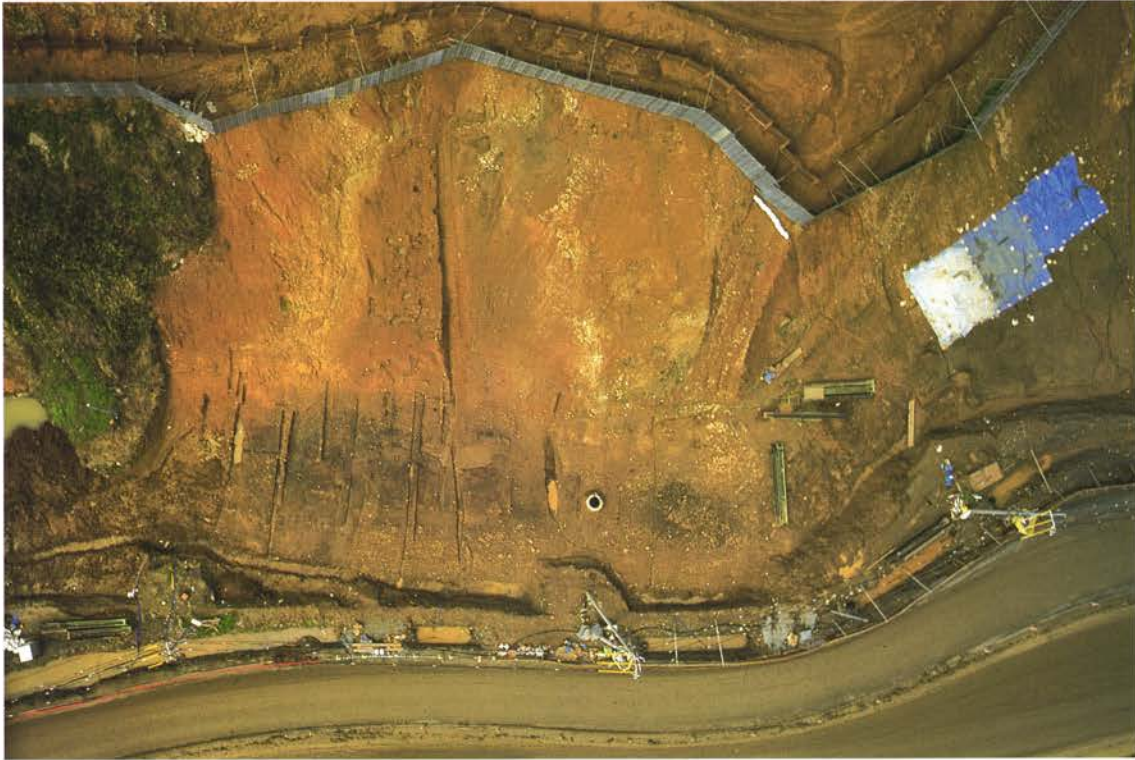
(1)O-2 地点全景 (真上から、上が北西)
