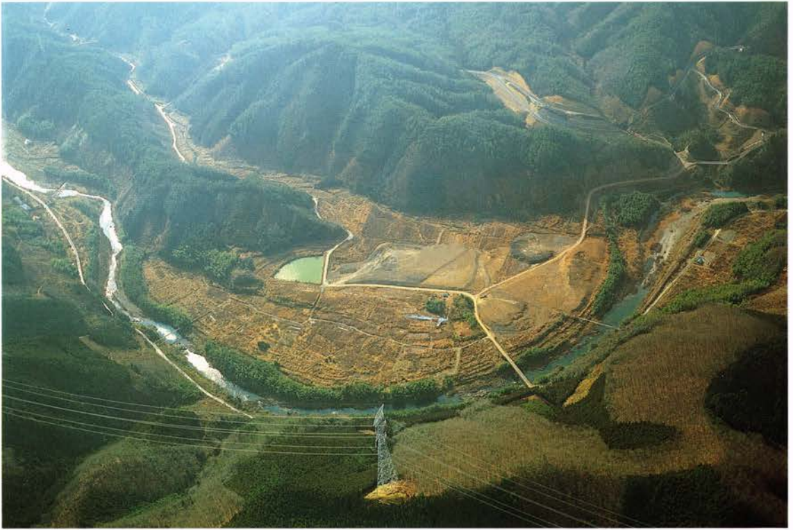
(1) 調査地全景 (1990.1. 北東から)
