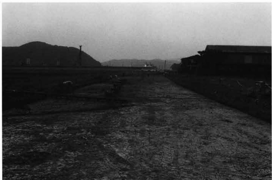
(3)第1トレンチ重機掘削後精査前 風景（北から）
