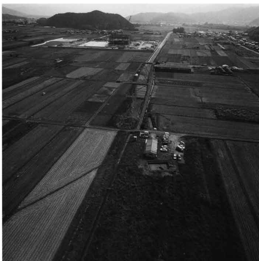
(2)調査地遠景（北上空から）
