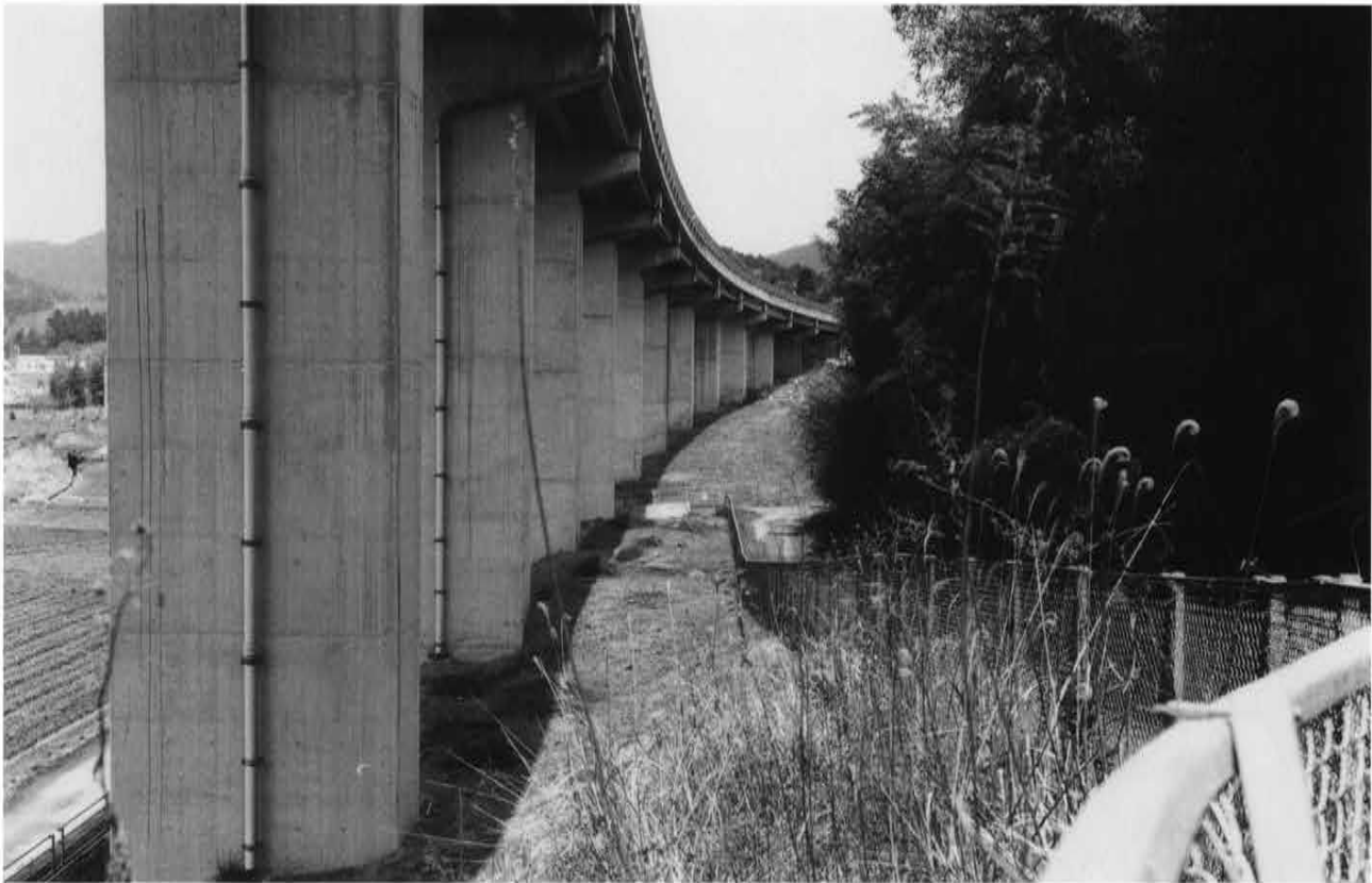
(2)調査前全景（南から）
