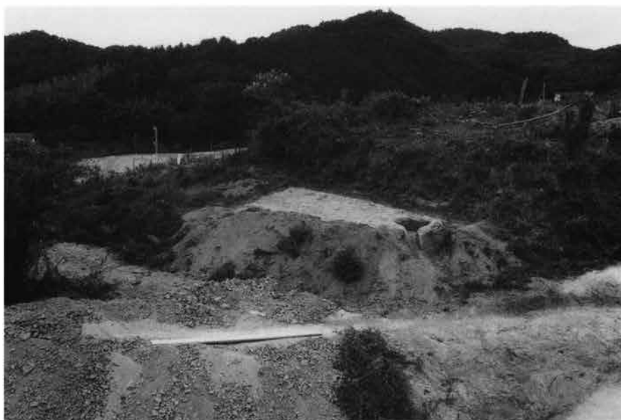
(2)南稲葉遺跡北西丘陵部掘削状況 (南から)
