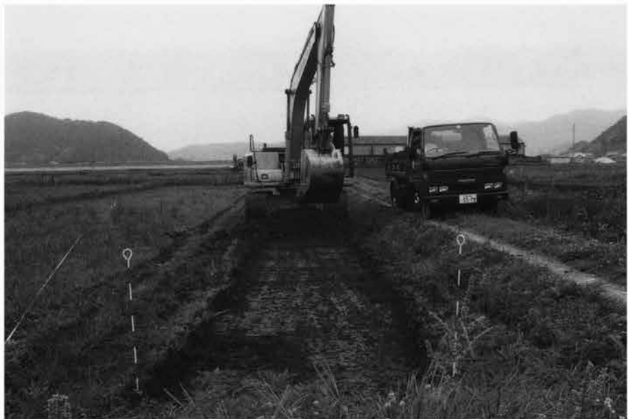
(2)重機掘削作業風景（北から）
