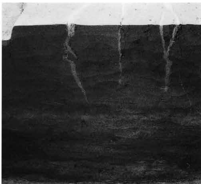
(4)液状化の断面形 (第88図2に対応、東から)
