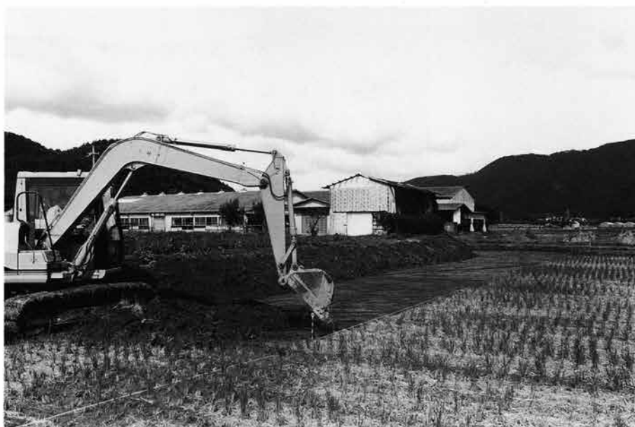
(2)第1トレンチ掘削風景 （南東から）
