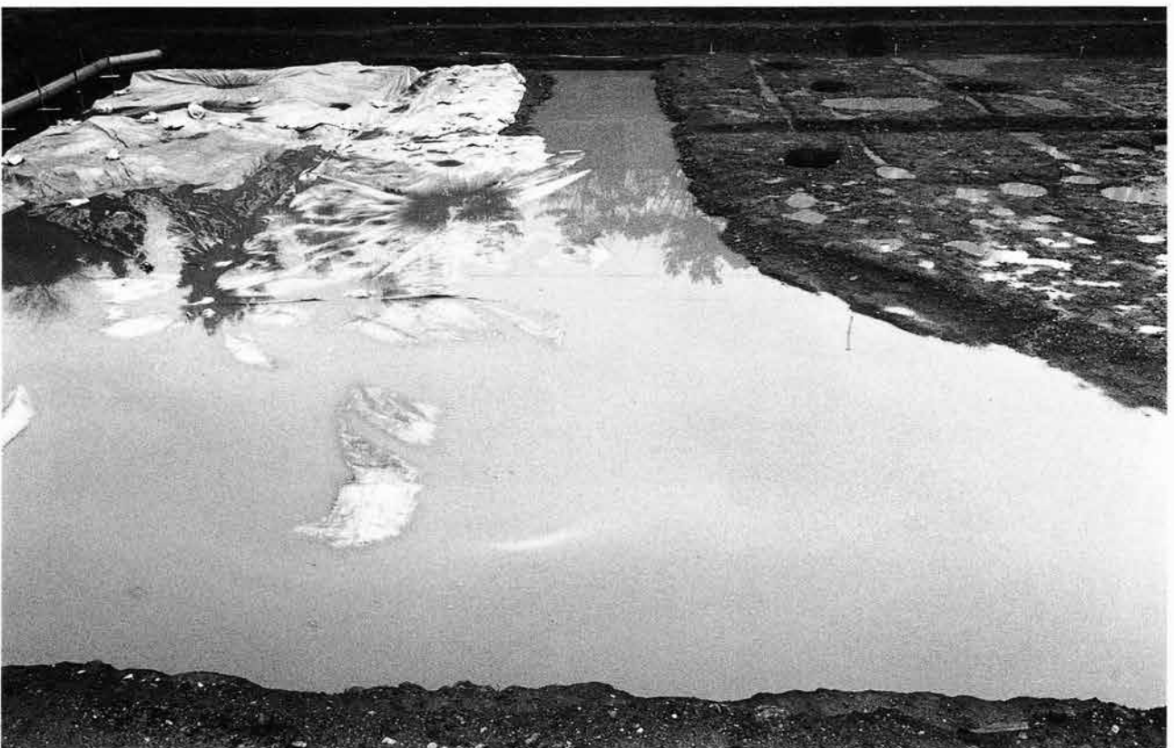
(2)池S G01滞水状況 (西から)
