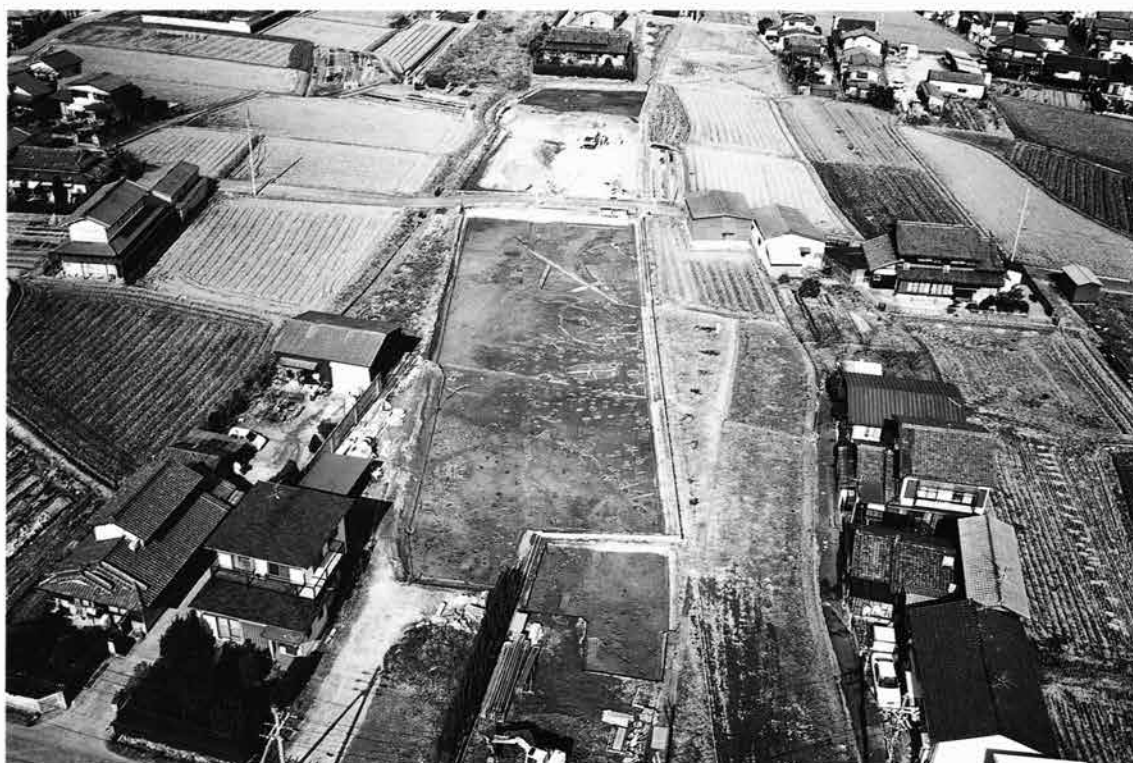
(1) B 1 - 3、C地区遠景（空中写真、南から）
