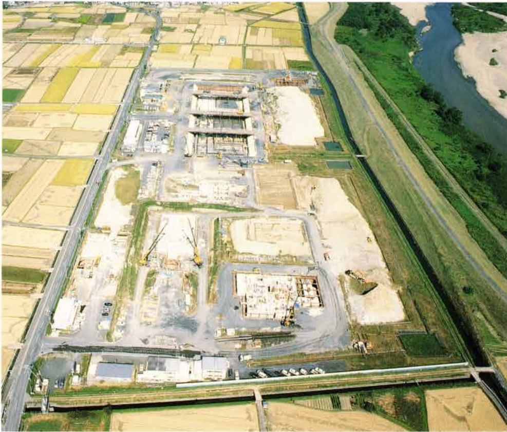
(1)調査地全景（南から）
