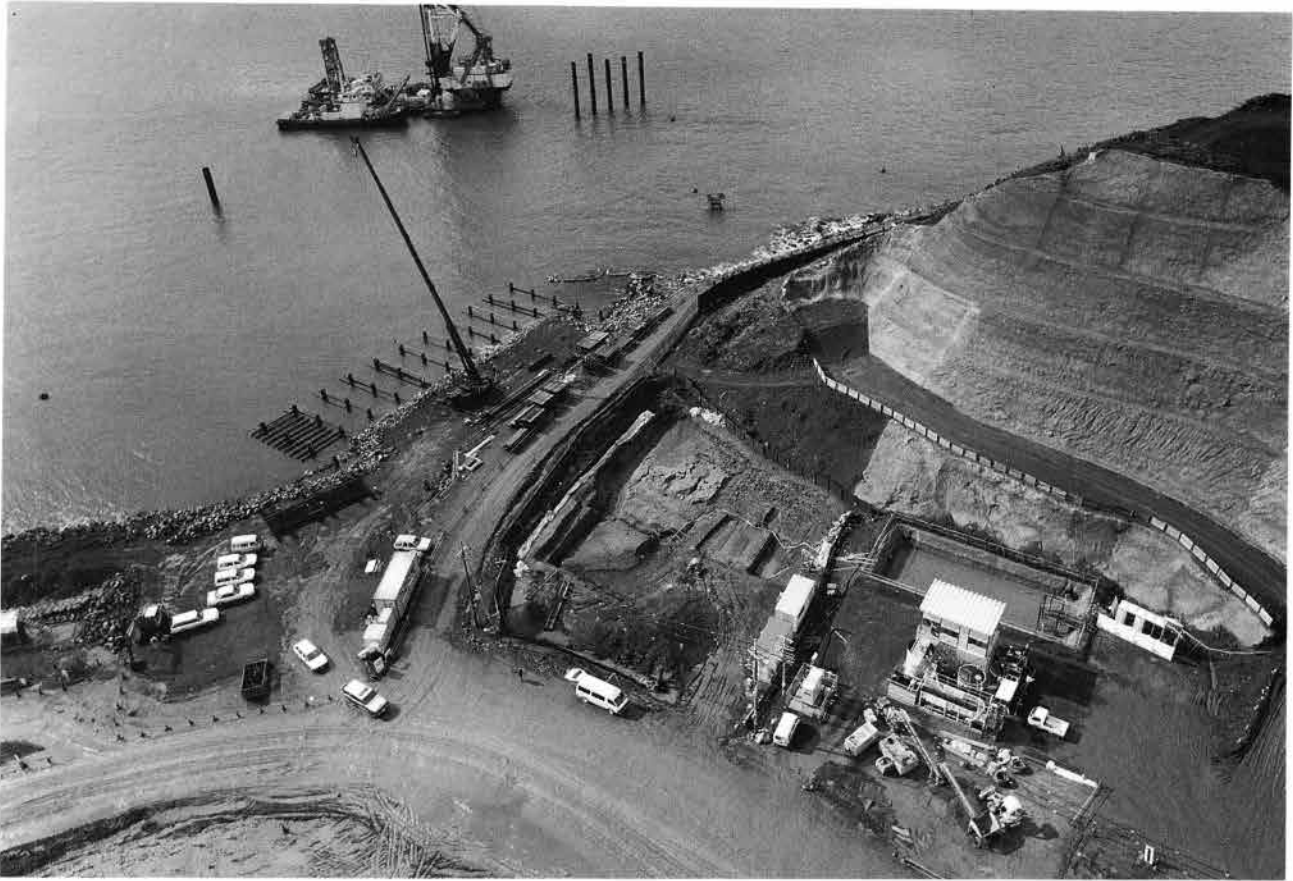
(1)R地点全景（北東から）
