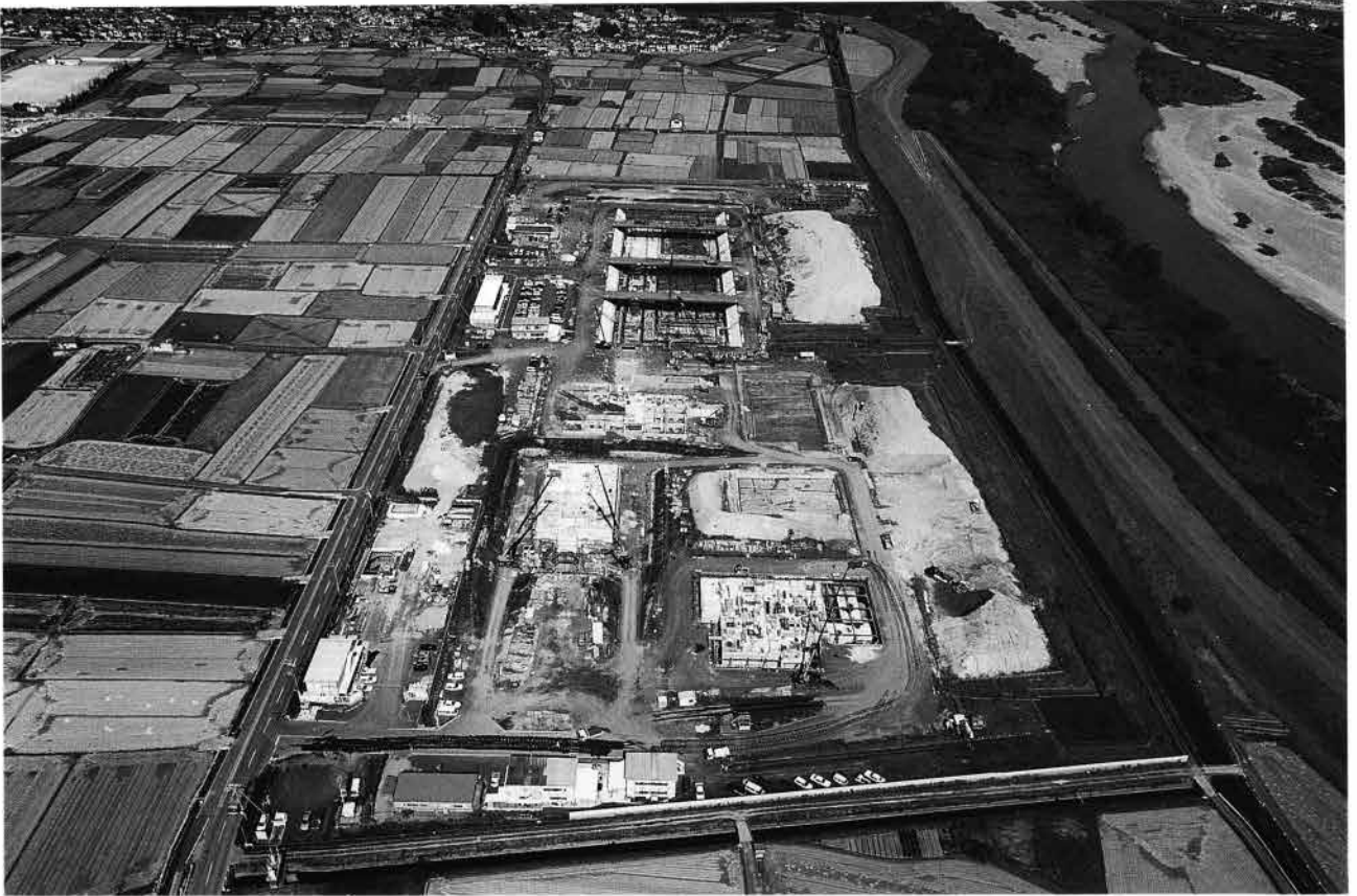
(1)調査地全景（南から）
