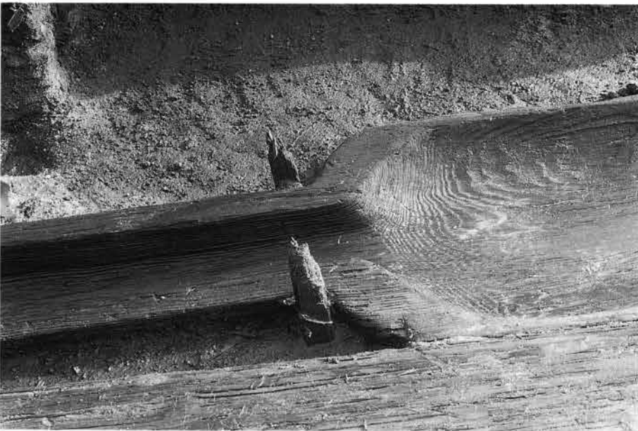
(2)導水施設本体 部分(2) (北から)
