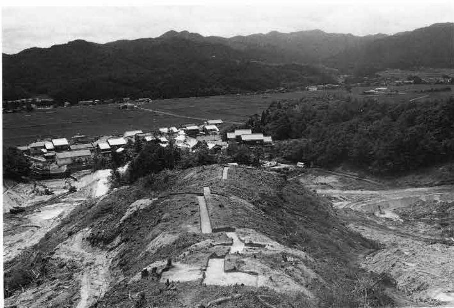
(1) C・D地区試掘トレンチ全景 (北から)
