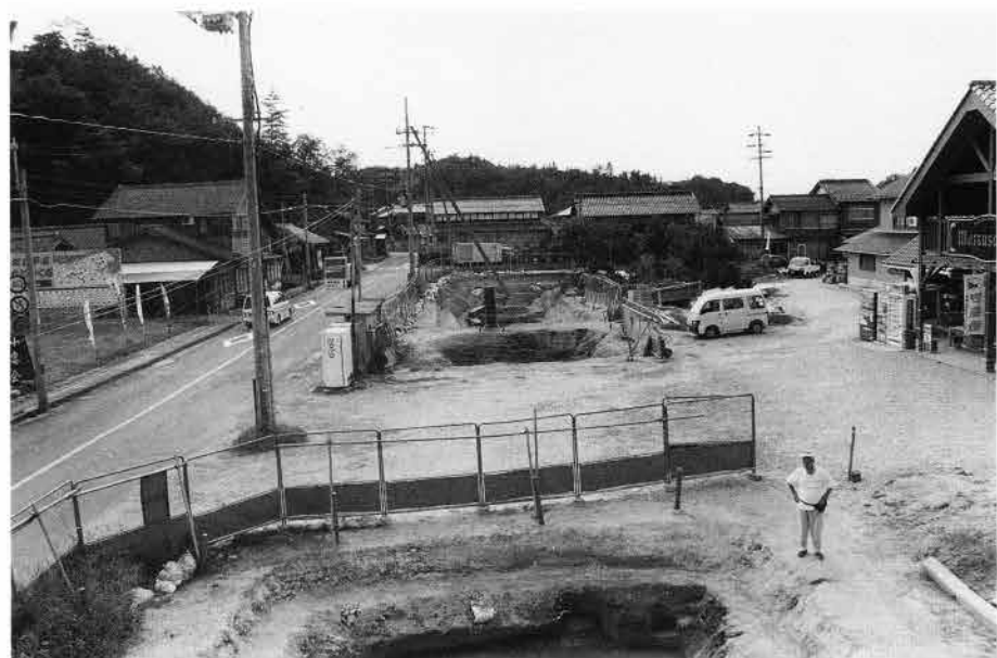
(3)調査地全景 (東から) 手前から第5・6・7・8 トレンチ
