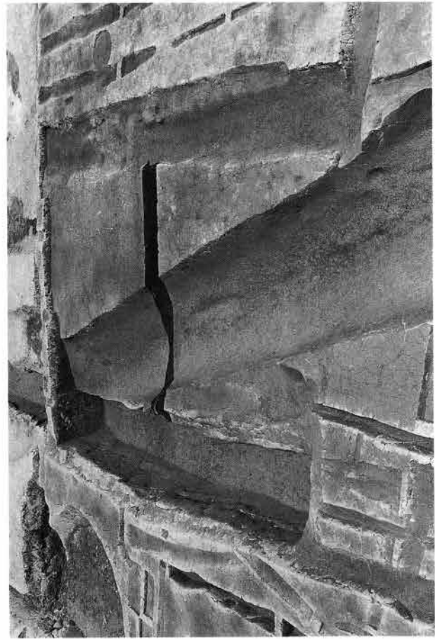
(2) 1 トレンチ S D 9501 検出状況 (S K 9504 と重複する部分、南から)
