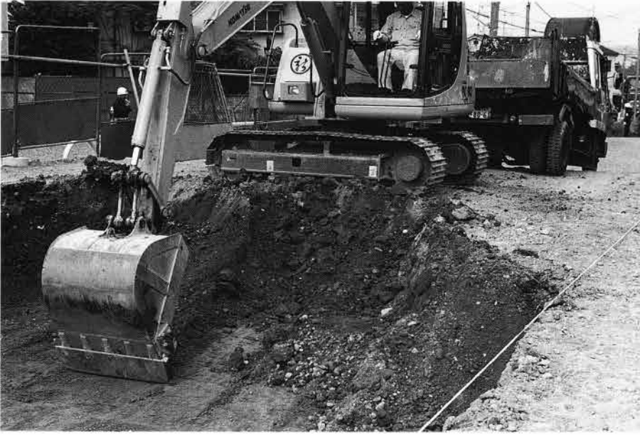
(1)第1トレンチ重機掘削状況
