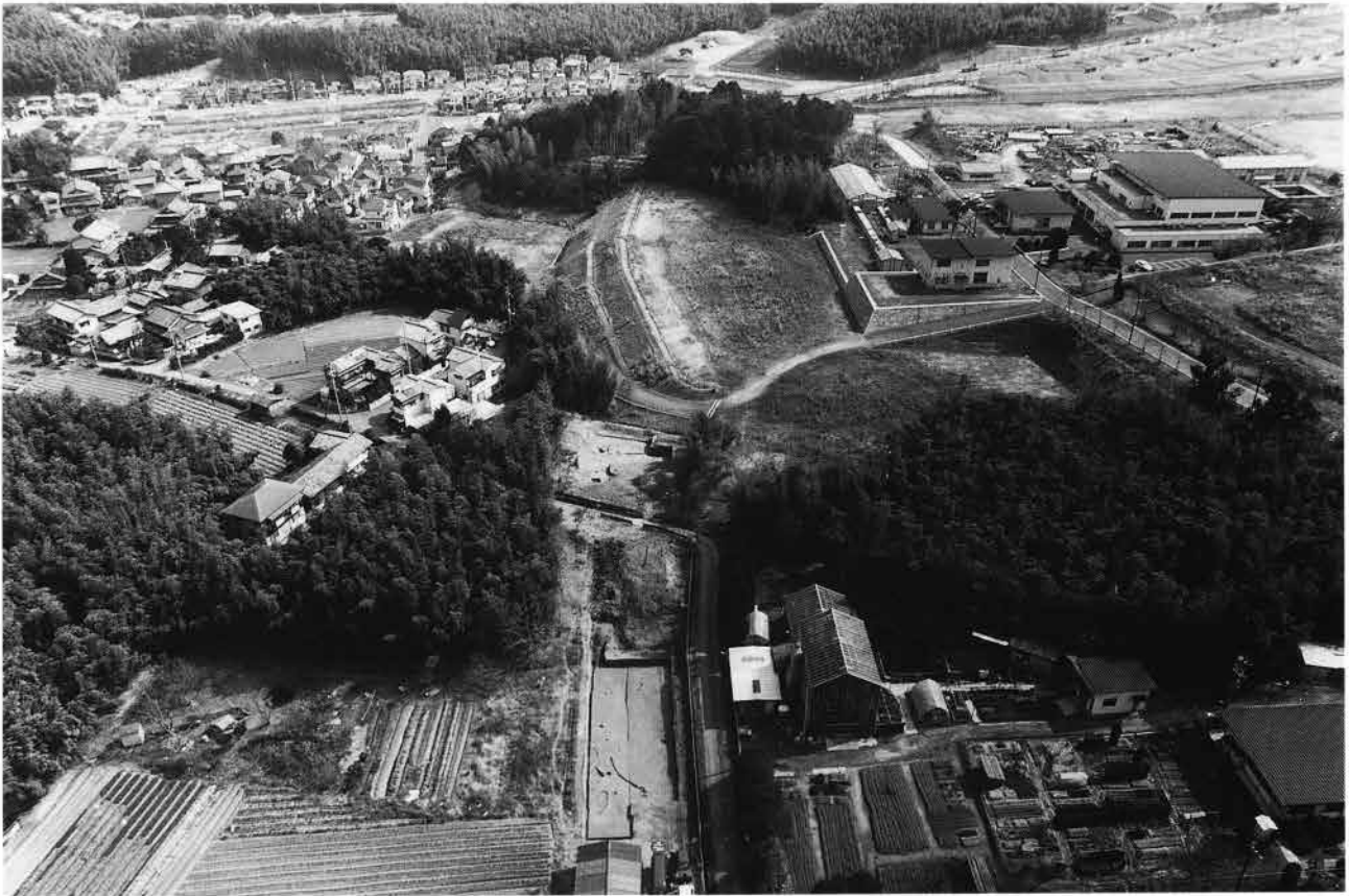
(1)平成8年度調査地全景（西から）
