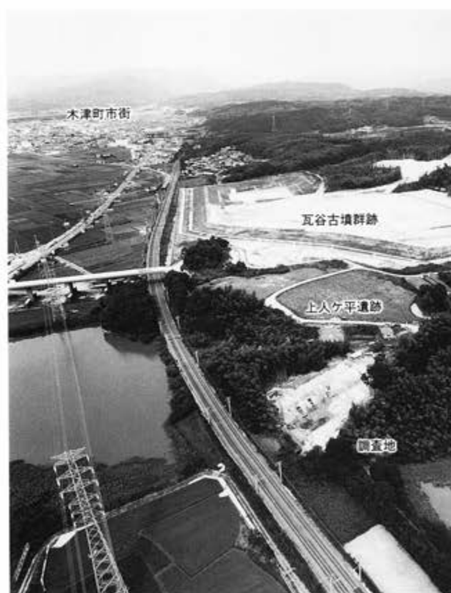
(3)調査地周辺 (南西から)
