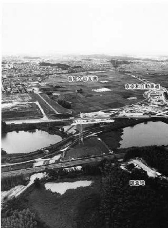
(2)調査地周辺 (南東から)
