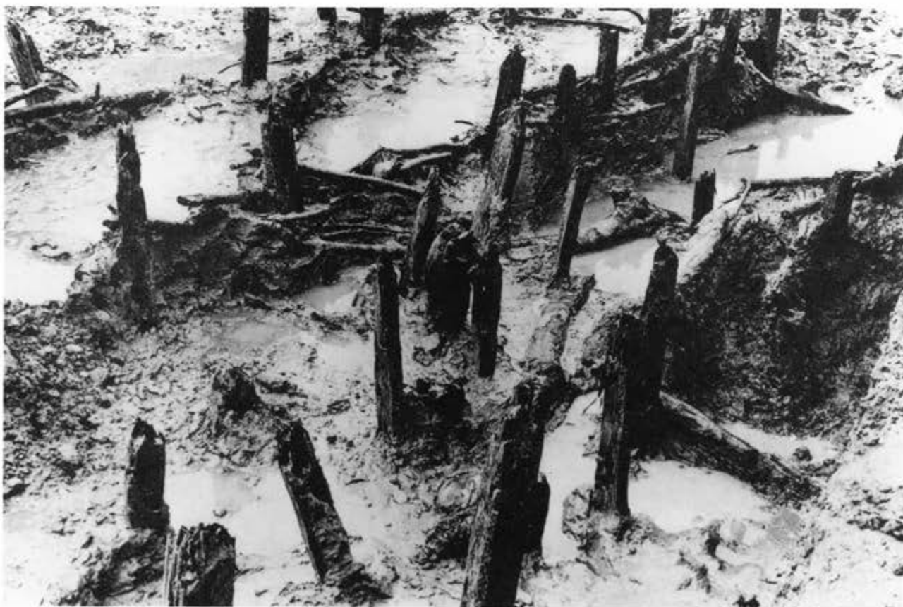
(2)左京第4次(府立向陽高校)杭列検出状況
