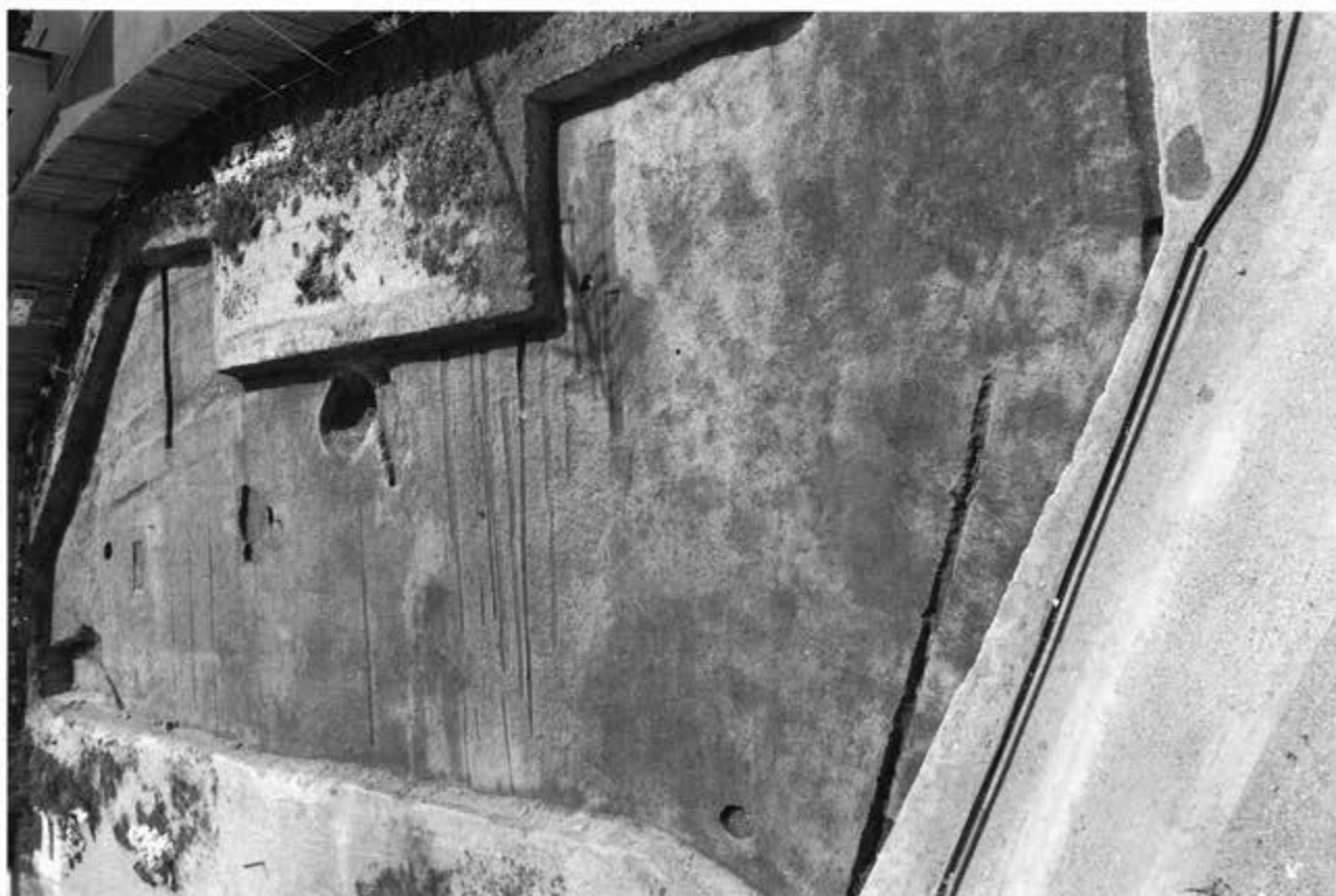
(1)第1トレンチ上面全景(北から)
