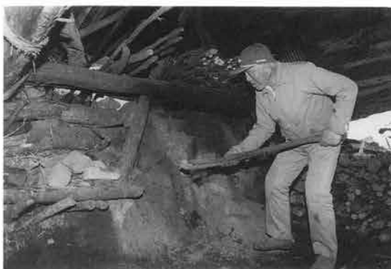
第7図 窯の口石をイシバサミで取り除く
