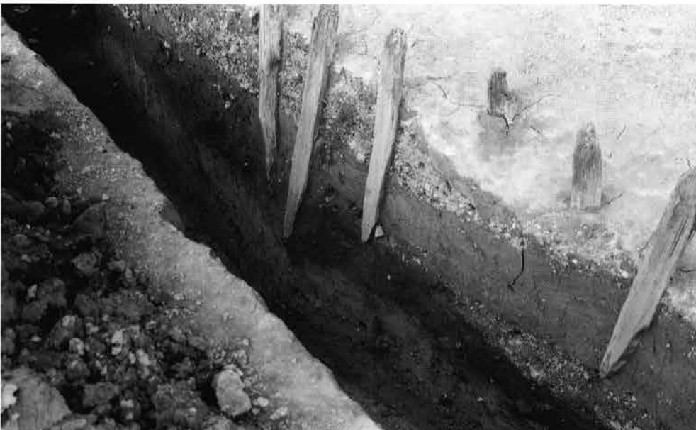
(3)第4トレンチ奈良時代杭列 S X36675断ち割り (南西から)
