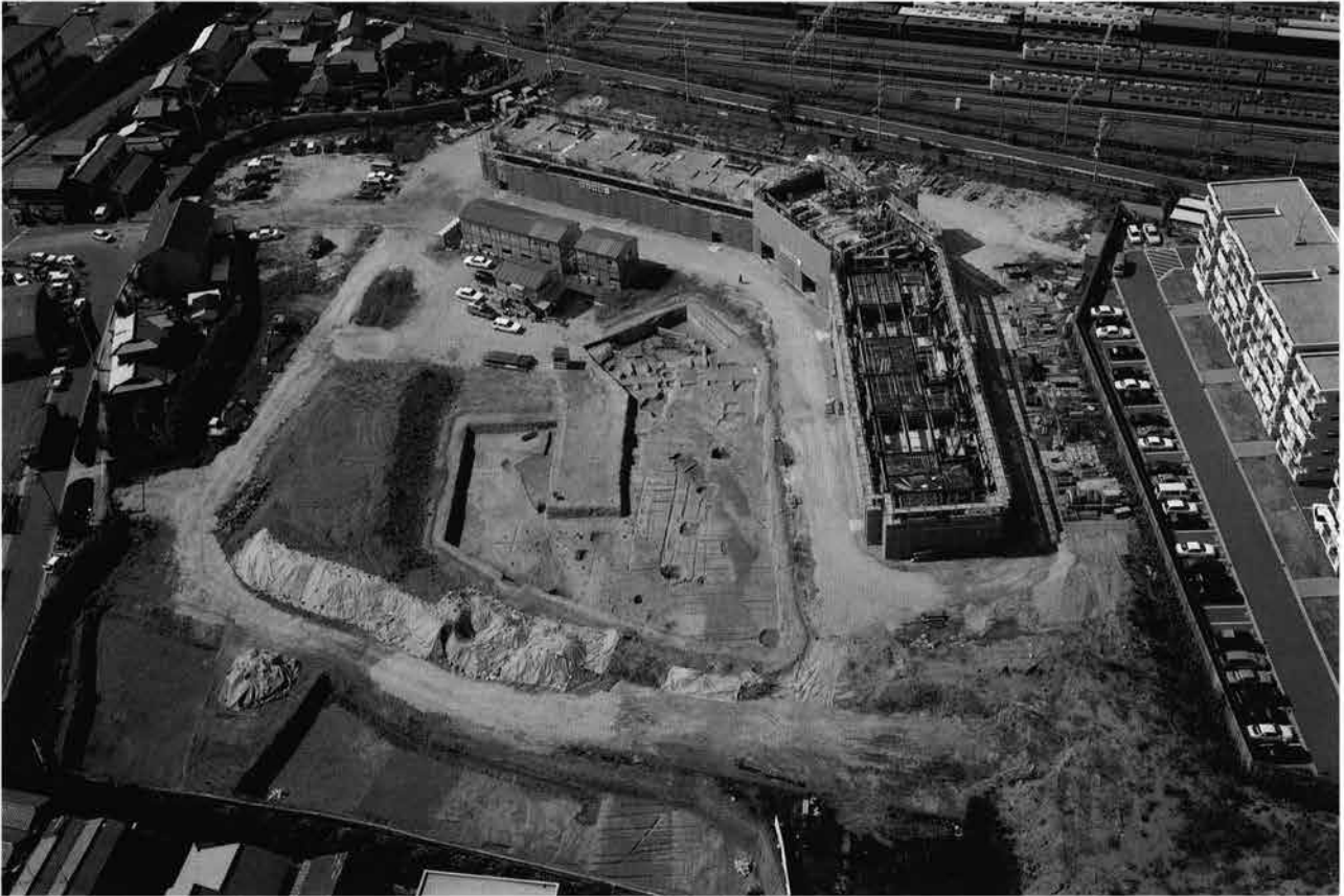
(1)調査地遠景（東から）
