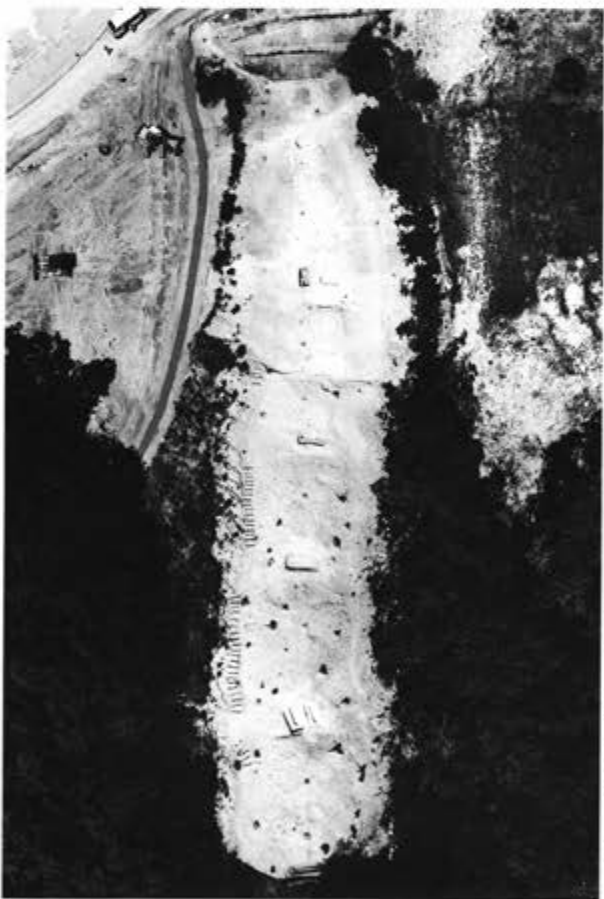
(1) 左坂古墳群C支群空中写真(東から)
