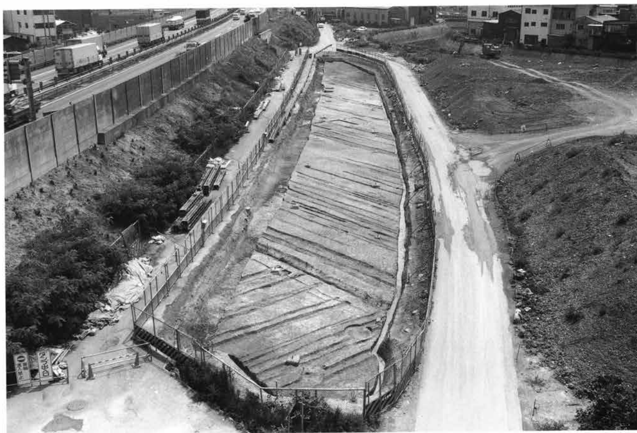
(1) A-3地区調査地全景（北東から）
