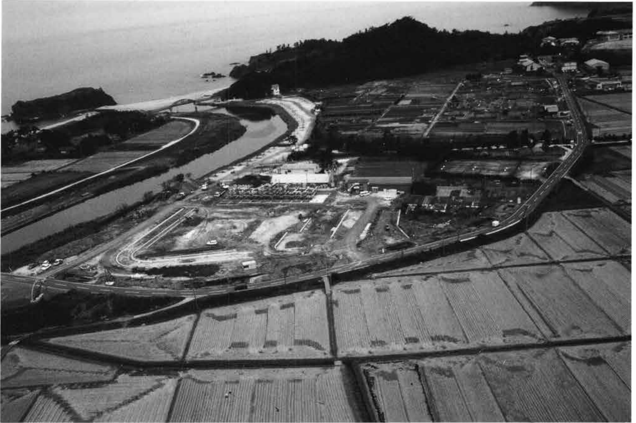
(1) 調査地遠景（南西から）
