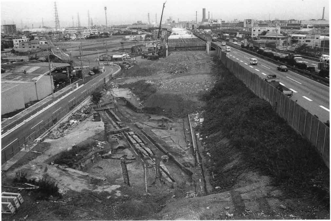
(1) C-6地区調査地全景（南西から）
