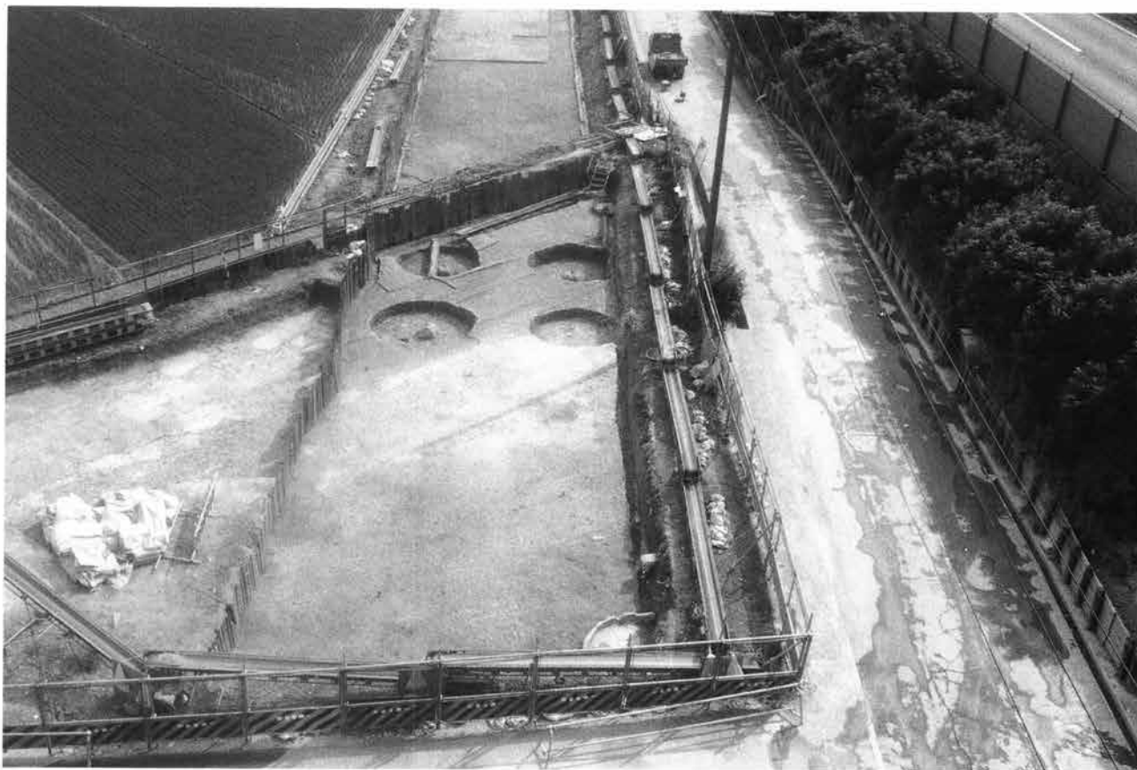
(1) B-2b地区調査地全景 (北東から)
