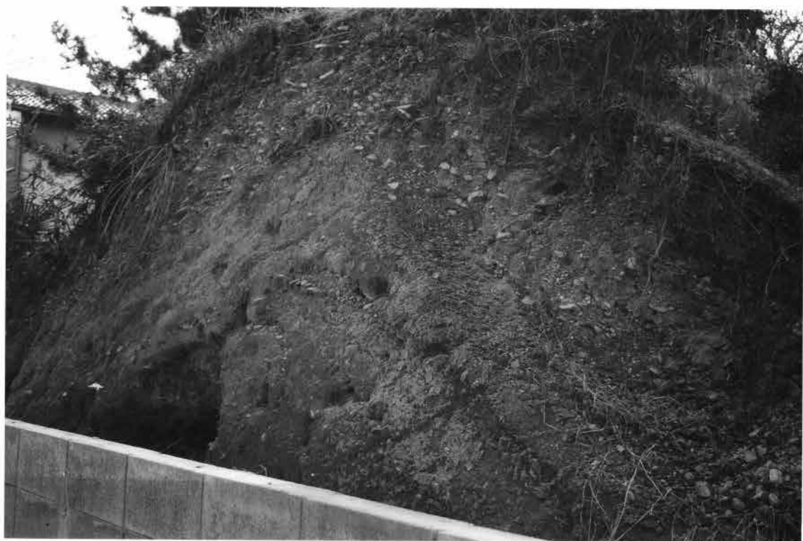
(2) 土塁断面 (京町、北東から)
