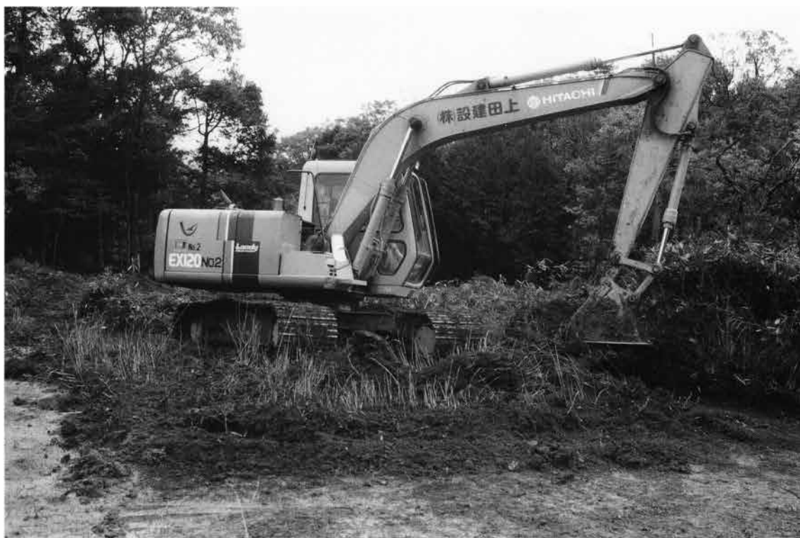
(2) 6トレンチ重機掘削作業（北西から）
