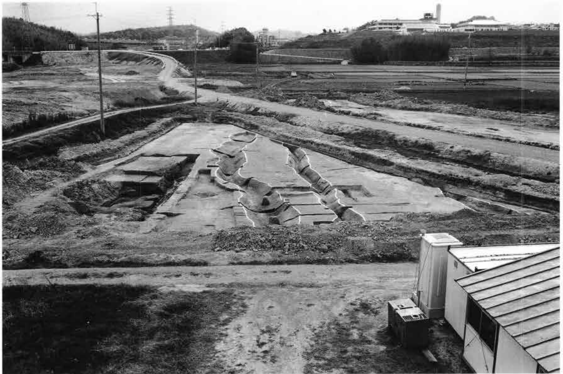
(2) AE 区下層遺構検出状況 (北から)
