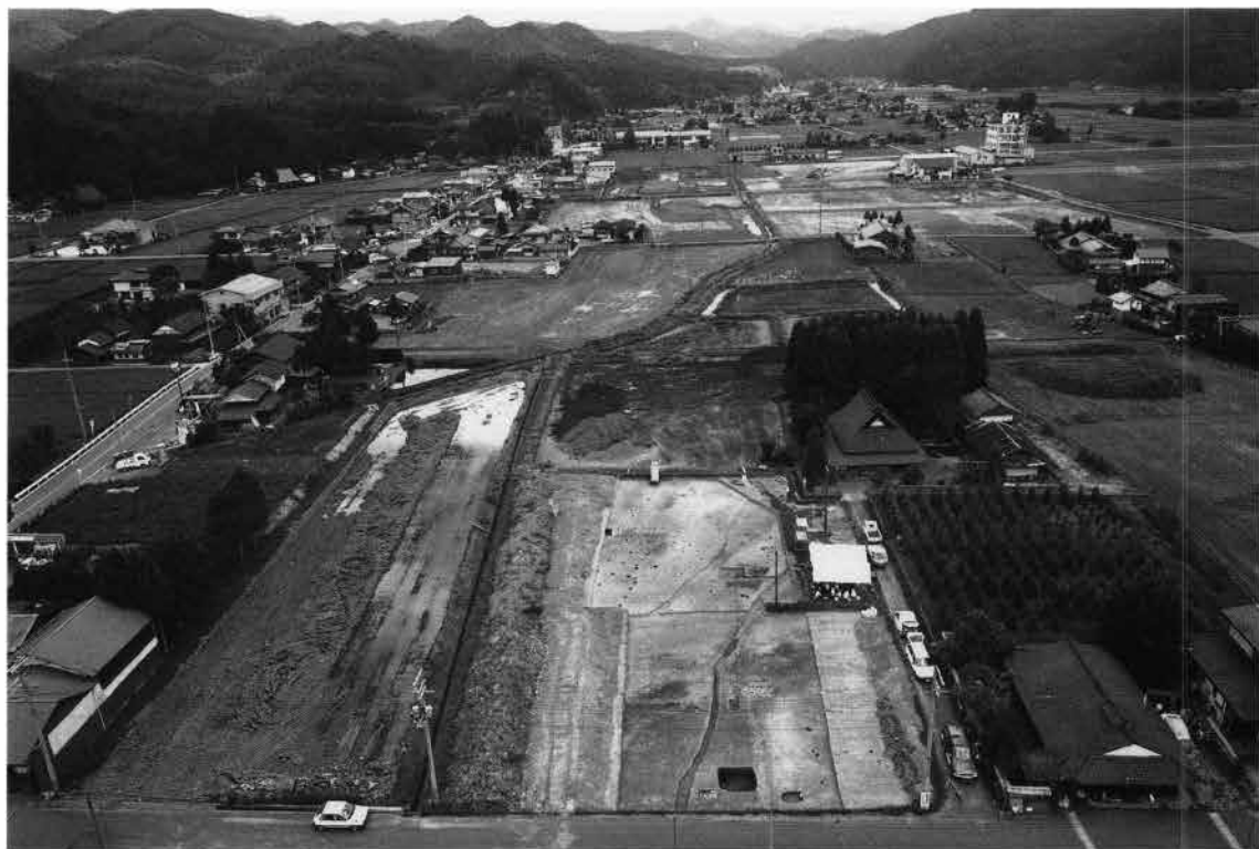
(1) 調査地遠景 (南方上空から)
