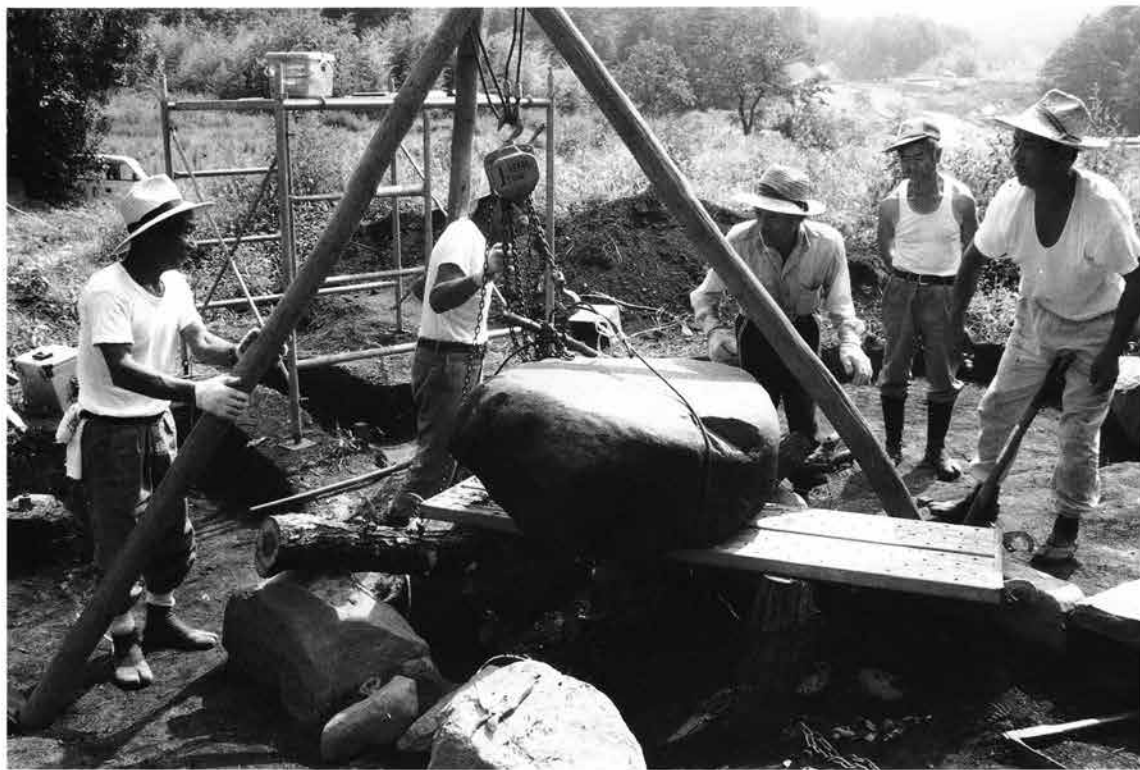
(1) 転落石除去作業風景
