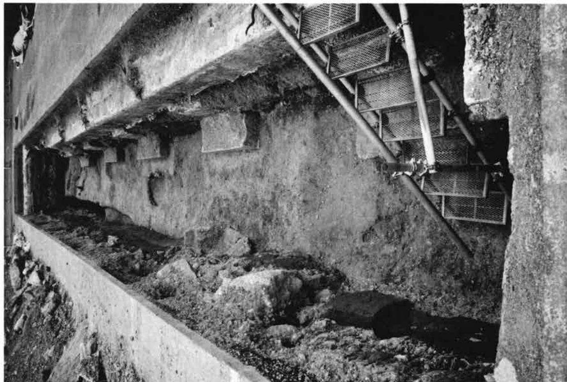
(1) Aトレンチ全景 (北から)
