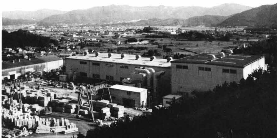
(1) 調査地遠景 (北から)
