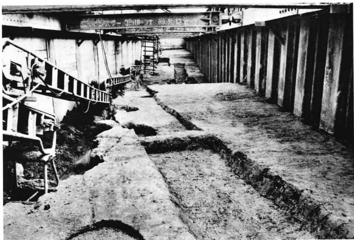
(1) 長岡京工区6ブロック第8トレンチ（北から）
