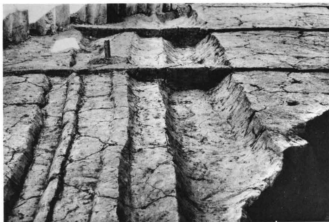
(2) 向日工区10ブロック 第12-2トレンチ
