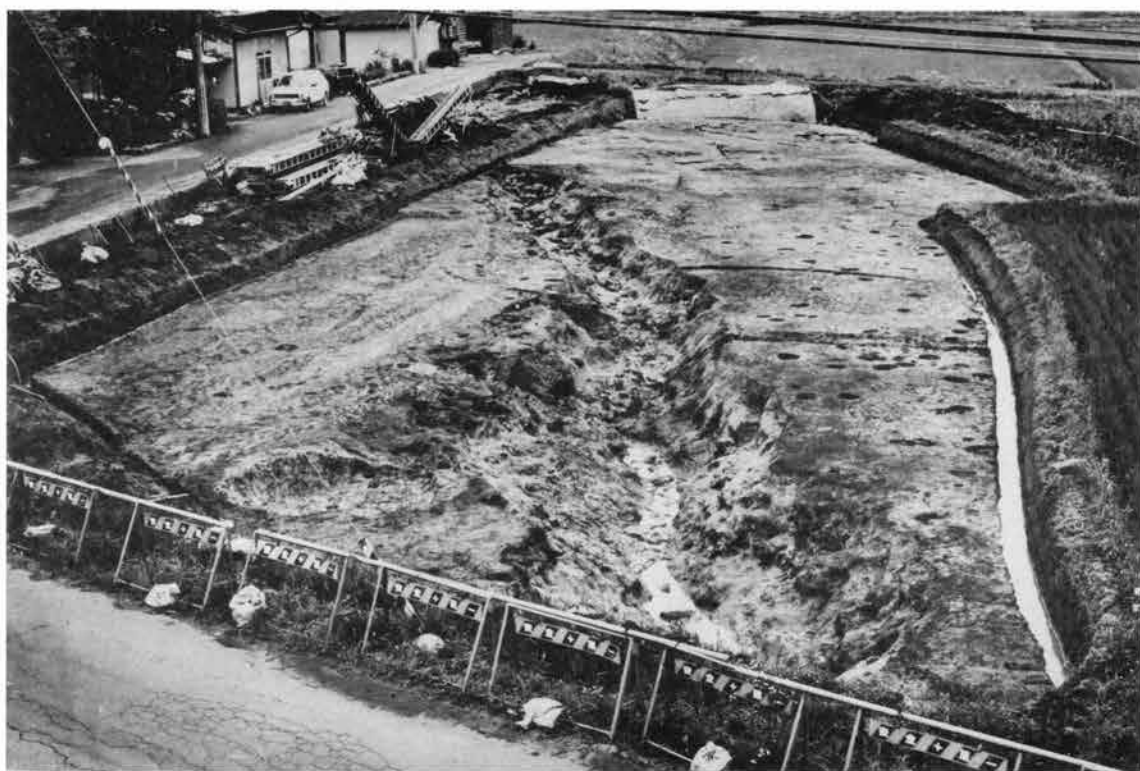
(1) 第2トレンチ完掘後全景（北から）
