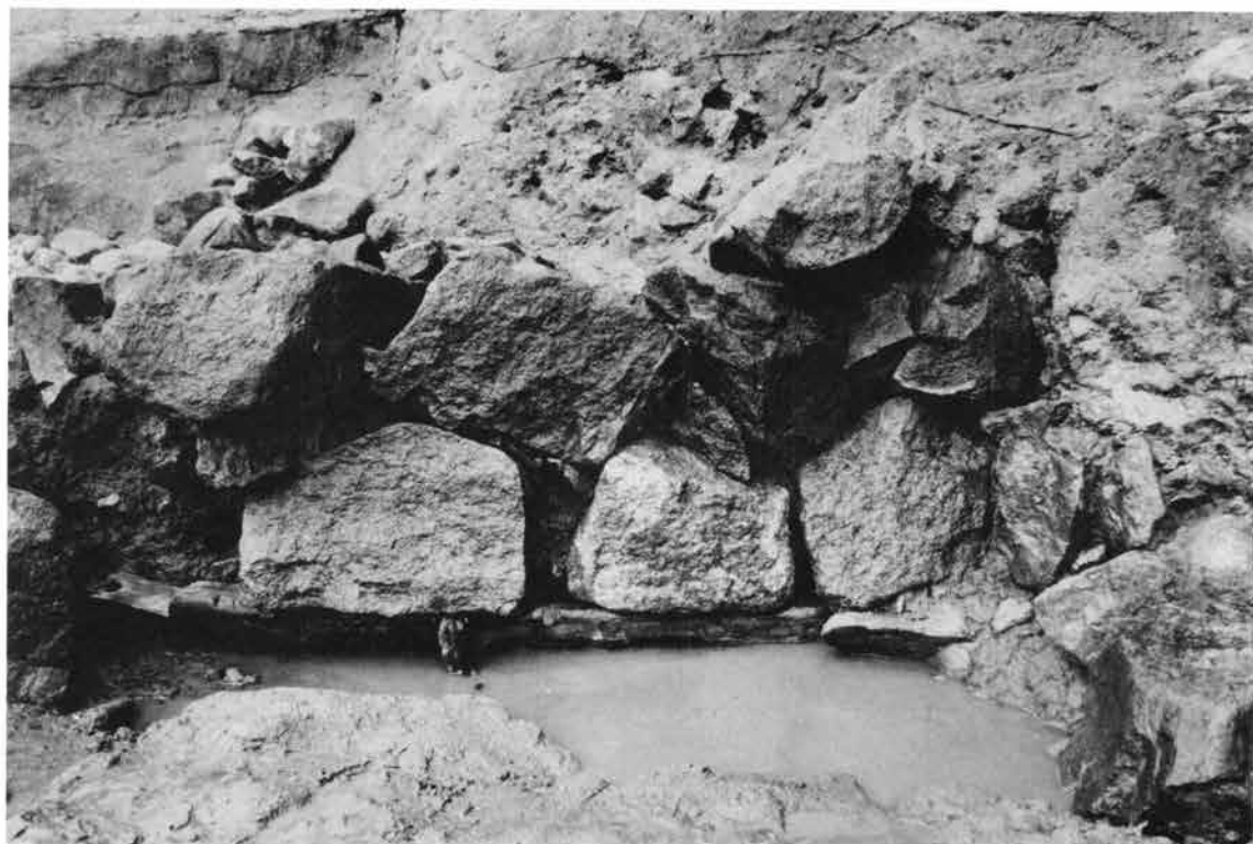
(1) 石垣1東側の胴木検出状況（南から）
