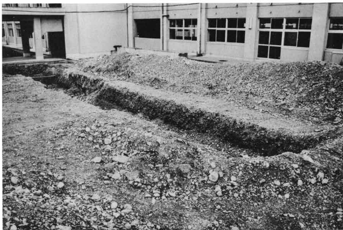
(2) 1トレンチ (南東から)
