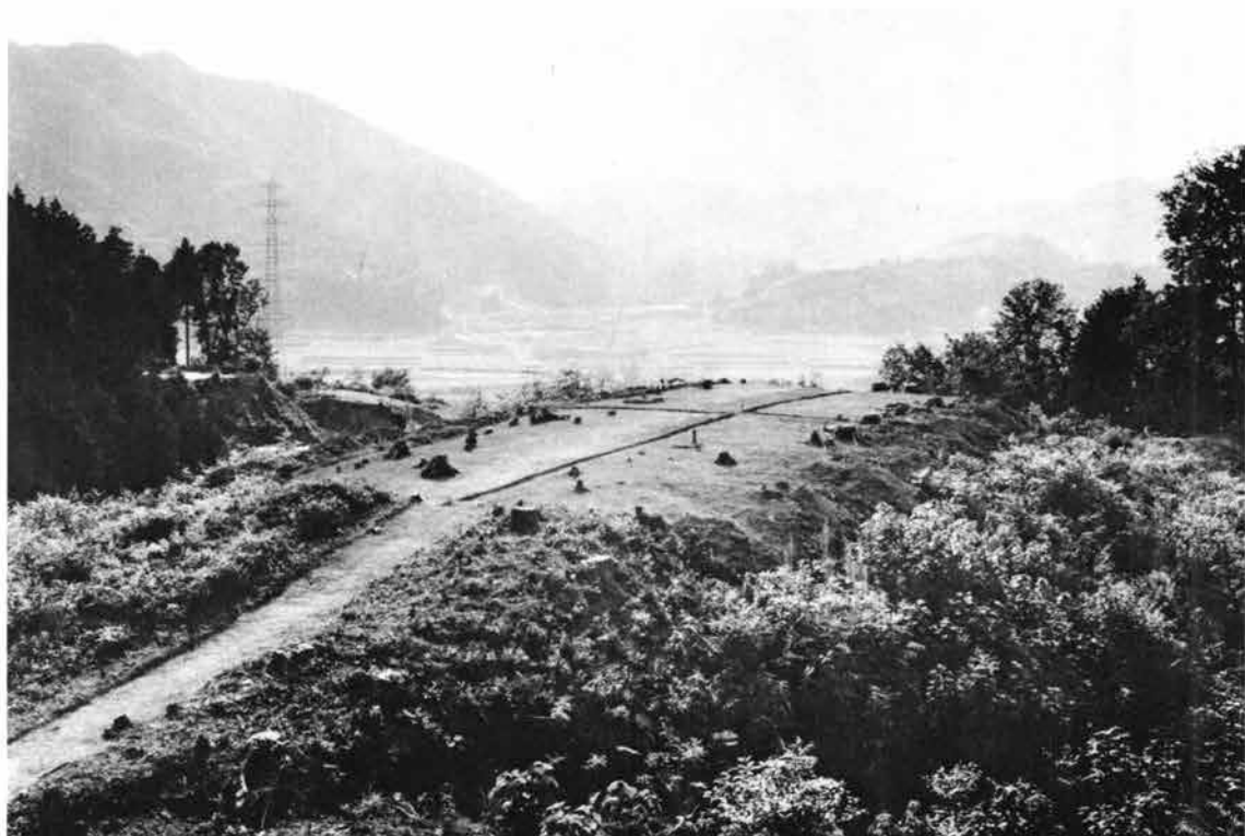
(1) E地点掘削状況
