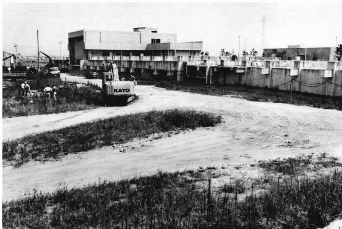
(1) 調査着手前全景 (西北から)
